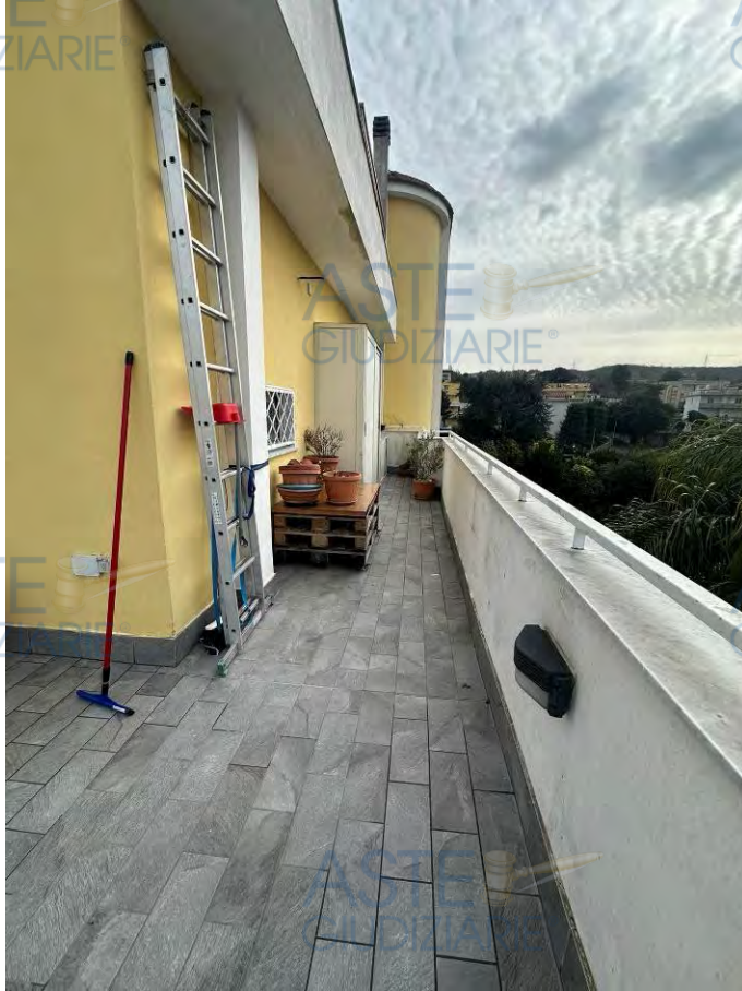
Foto 22 – Balcone b2 lato SudOvest
