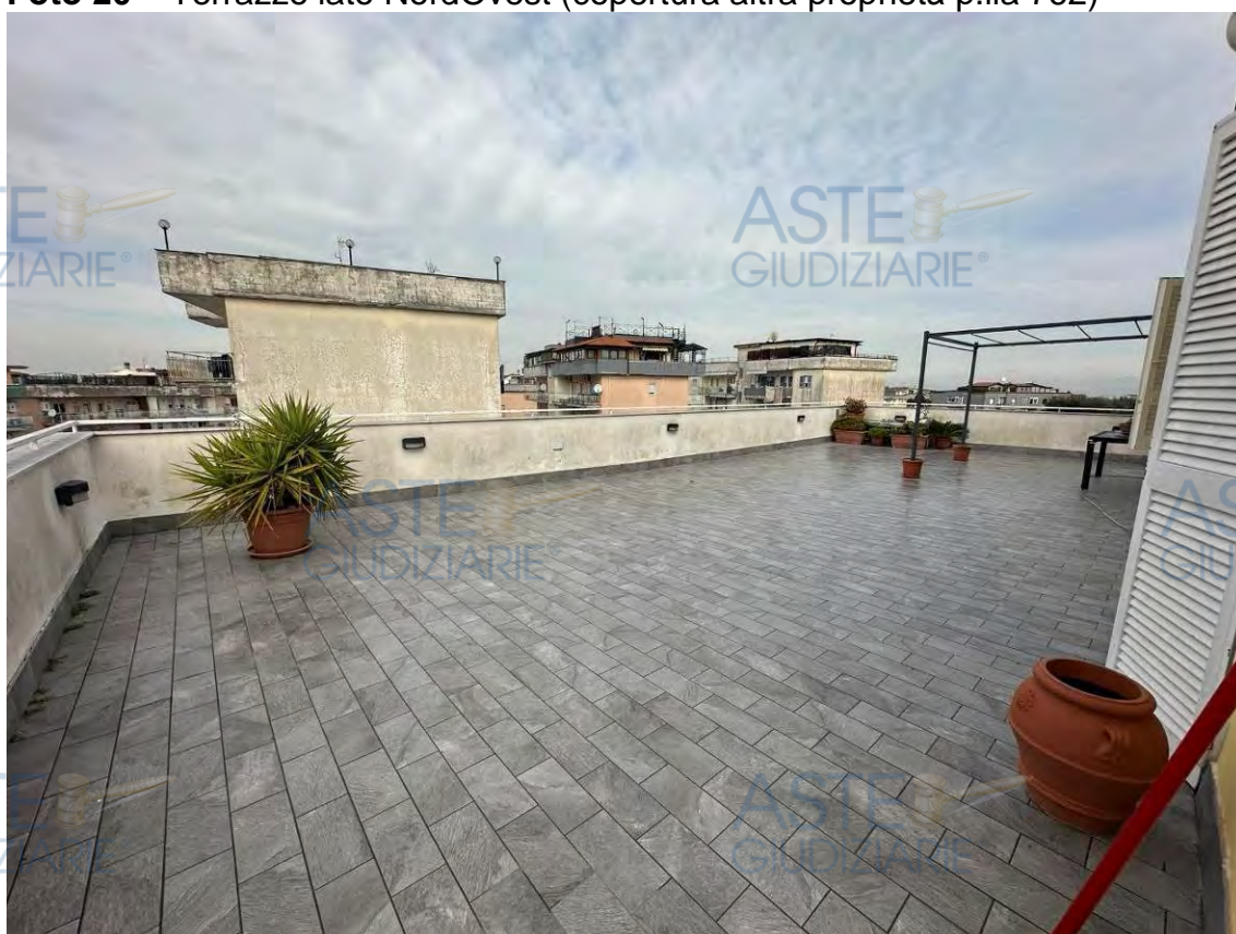
Foto 21 – Terrazzo lato NordOvest (copertura altra proprietà p.Ila 762)
