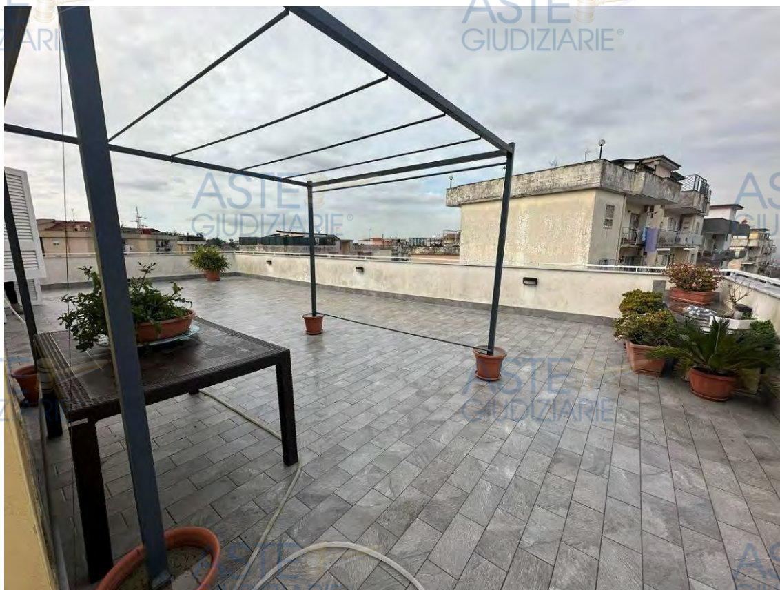
Foto 20 – Terrazzo lato NordOvest (copertura altra proprietà p.Ila 762)
