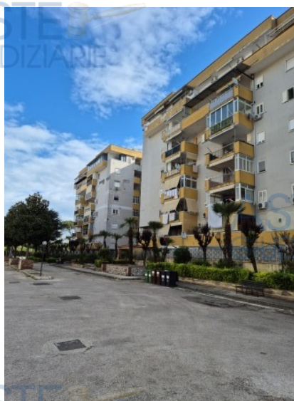
Figura 9 facciata ovest del Fabbricato B3 del lotto B del parco Aurora in Melito di Napoli
