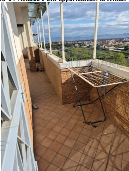
Figura 26 balcone dell'appartamento al settimo piano
