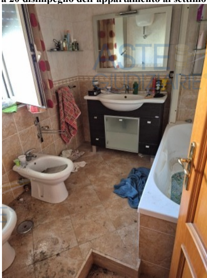
Figura 22 bagno 1 dell'appartamento al settimo piano
