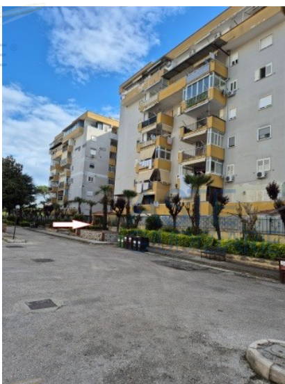
Figura 8 facciata ovest del Fabbricato B3 del lotto B del parco Aurora in Melito di Napoli
