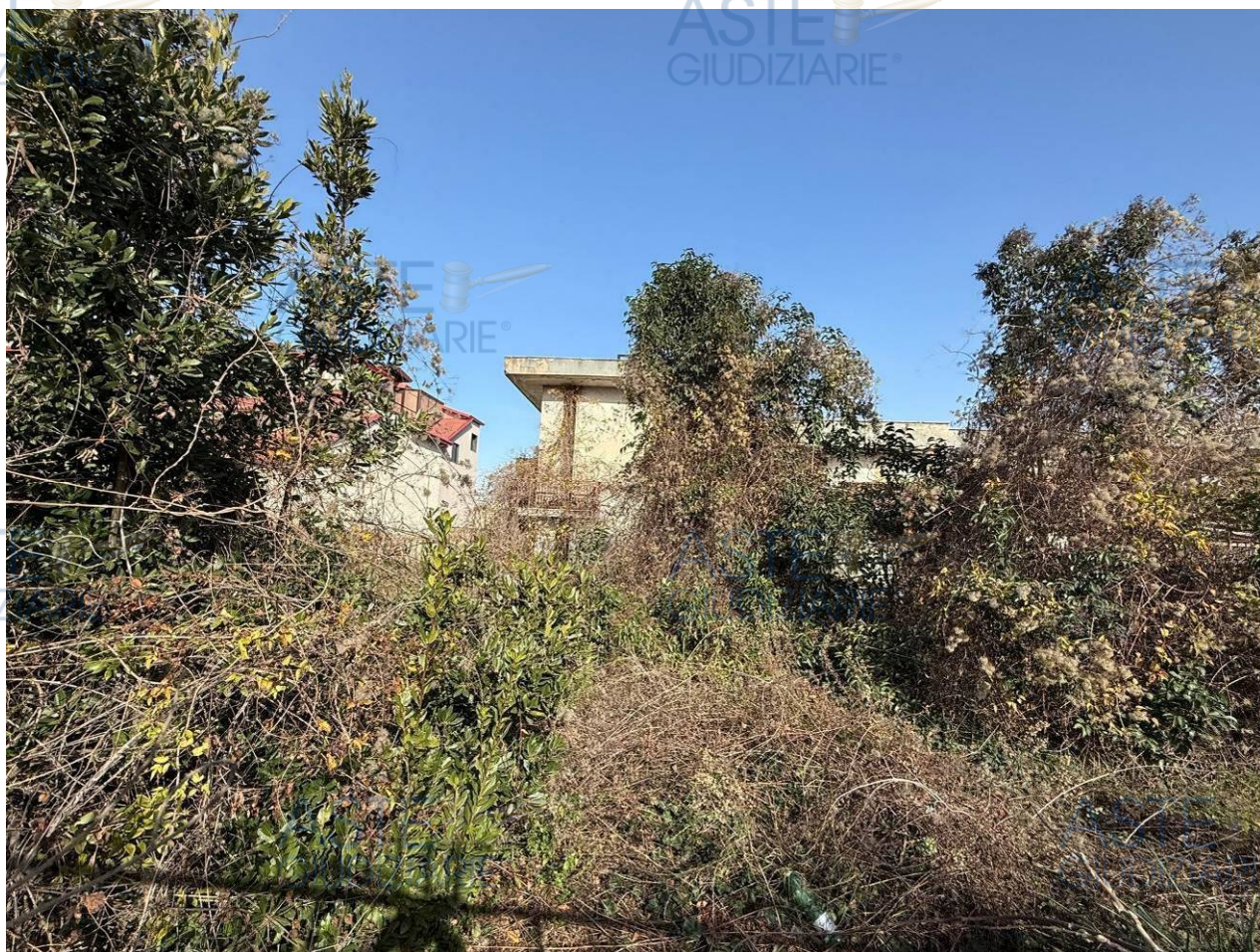
Foto 03 – Il fabbricato dal giardino pertinenziale p.lla 1837 CT
