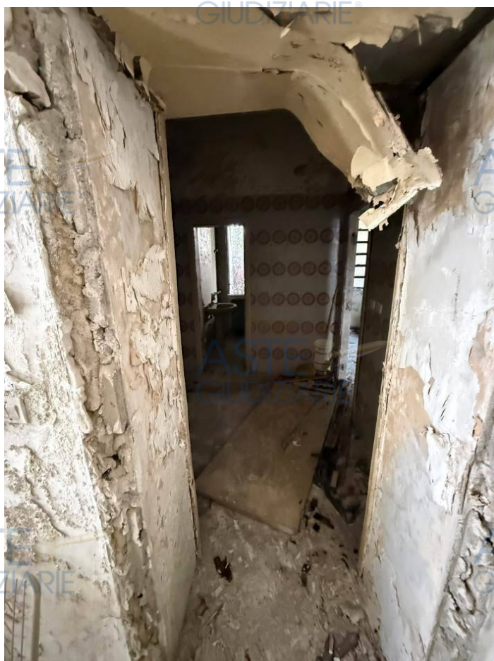
Foto 16 – L'ingresso dalle scale che collegano dall'esterno il piano rialzato ed il piano copertura
