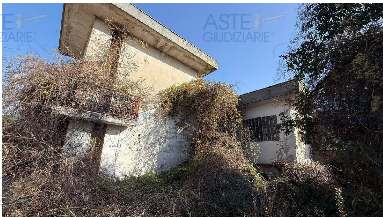
Foto 04 – Il fabbricato dal giardino pertinenziale p.lla 1837 CT
