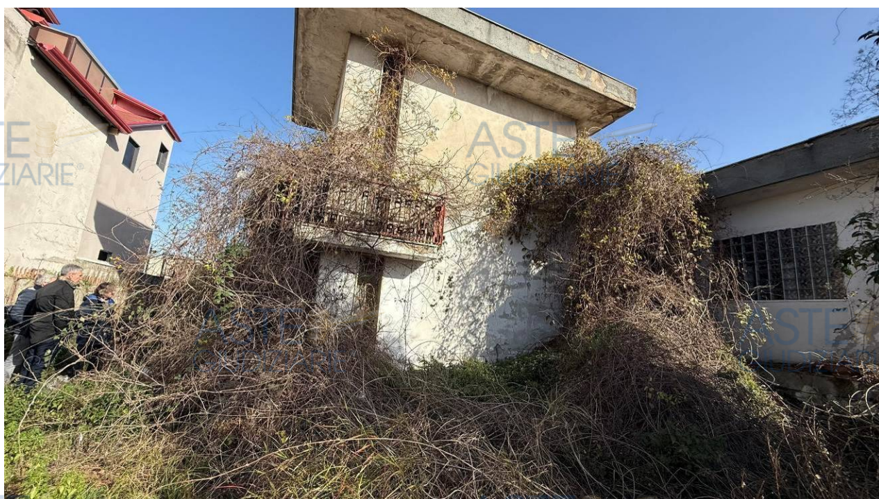
Foto 06 – Il fabbricato dal giardino pertinenziale p.lla 1837 CT
