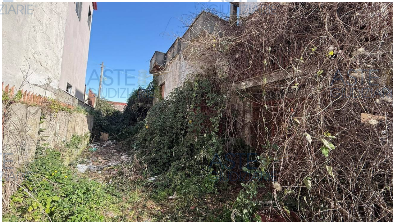
Foto 05 – Il fabbricato dal giardino pertinenziale p.lla 1837 CT
