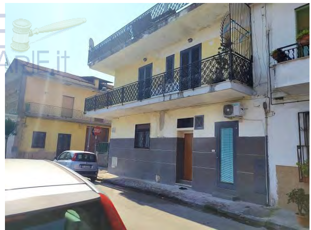
Vista da Via Garibaldi
