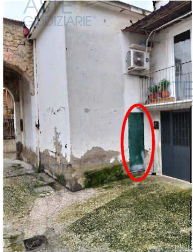
Figura 6- Porta esterna di accesso al cortile
