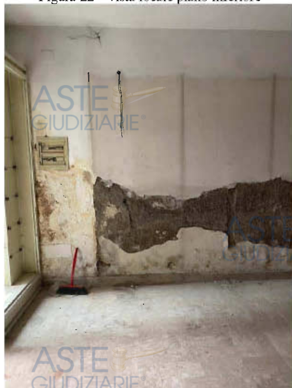
Figura 24 – vista 3 locale piano inferiore
