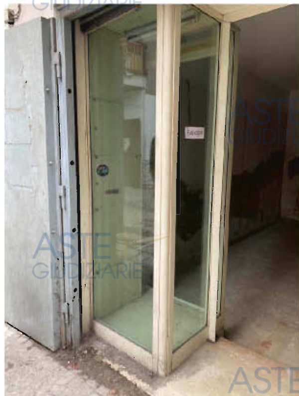
Figura 22 – vista locale piano inferiore
