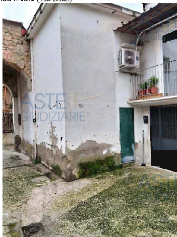
Figura 9 – vista confine nord (cortile interno)
