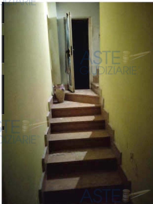
Figura 10 – scala di accesso al piano superiore
