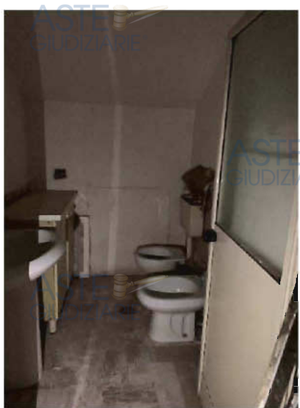
Figura 30 – particolare locale bagno piano inferiore
