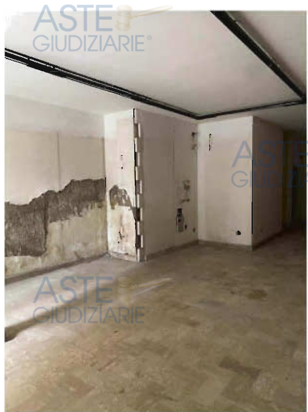
Figura 26 – vista 5 locale piano inferiore
