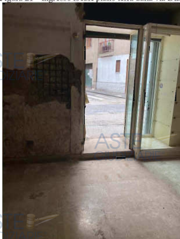
Figura 23 – vista 2 locale piano inferiore
