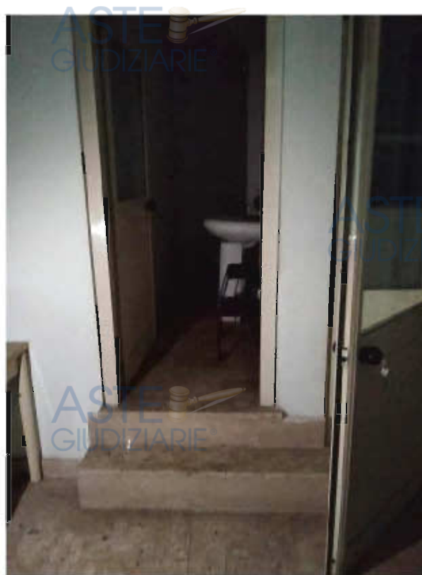
Figura 19 – ingresso bagno piano superiore
