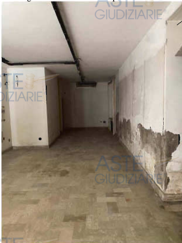
Figura 27 – vista 6 locale piano inferiore
