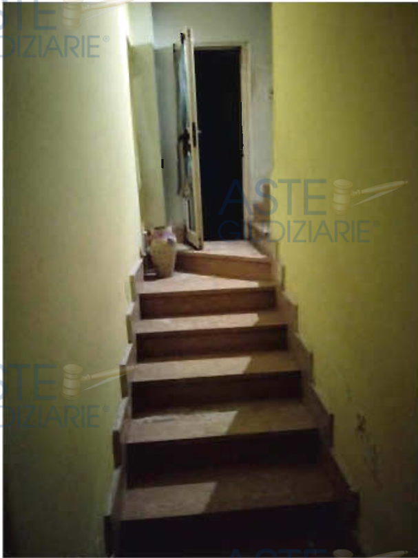
Figura 5- Porta interna di accesso al cortile
