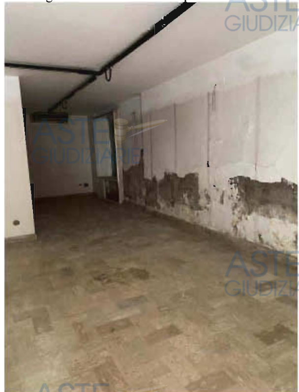
Figura 28 – vista 7 locale piano inferiore
