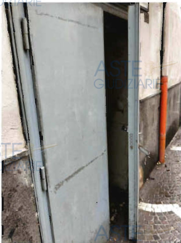
Figura 21 – ingresso locale piano terra dalla via Diaz
