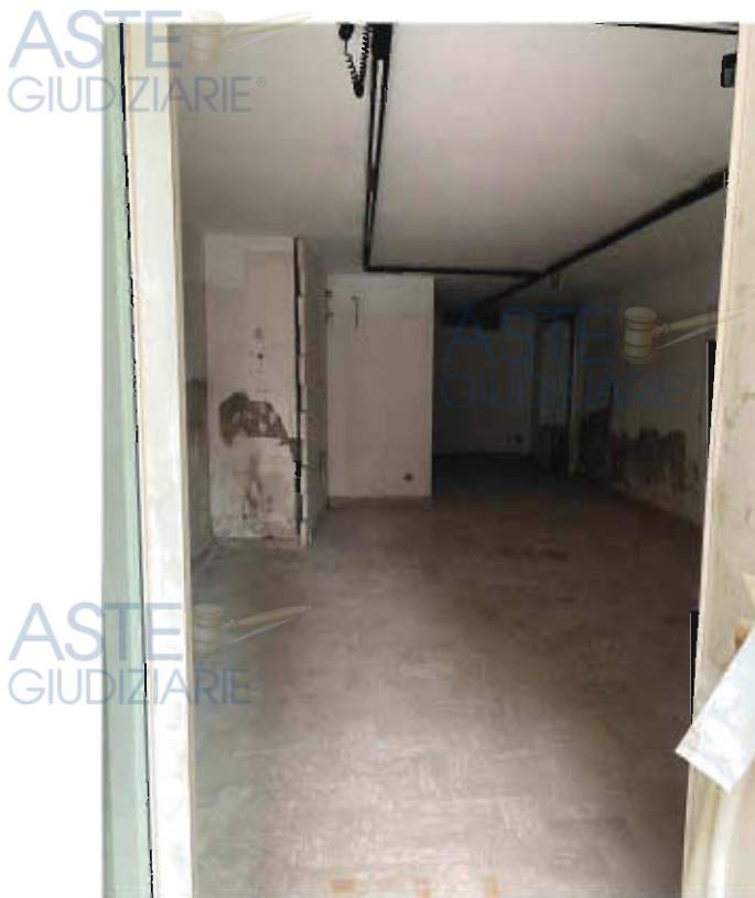
Figura 25 – vista 4 locale piano inferiore
