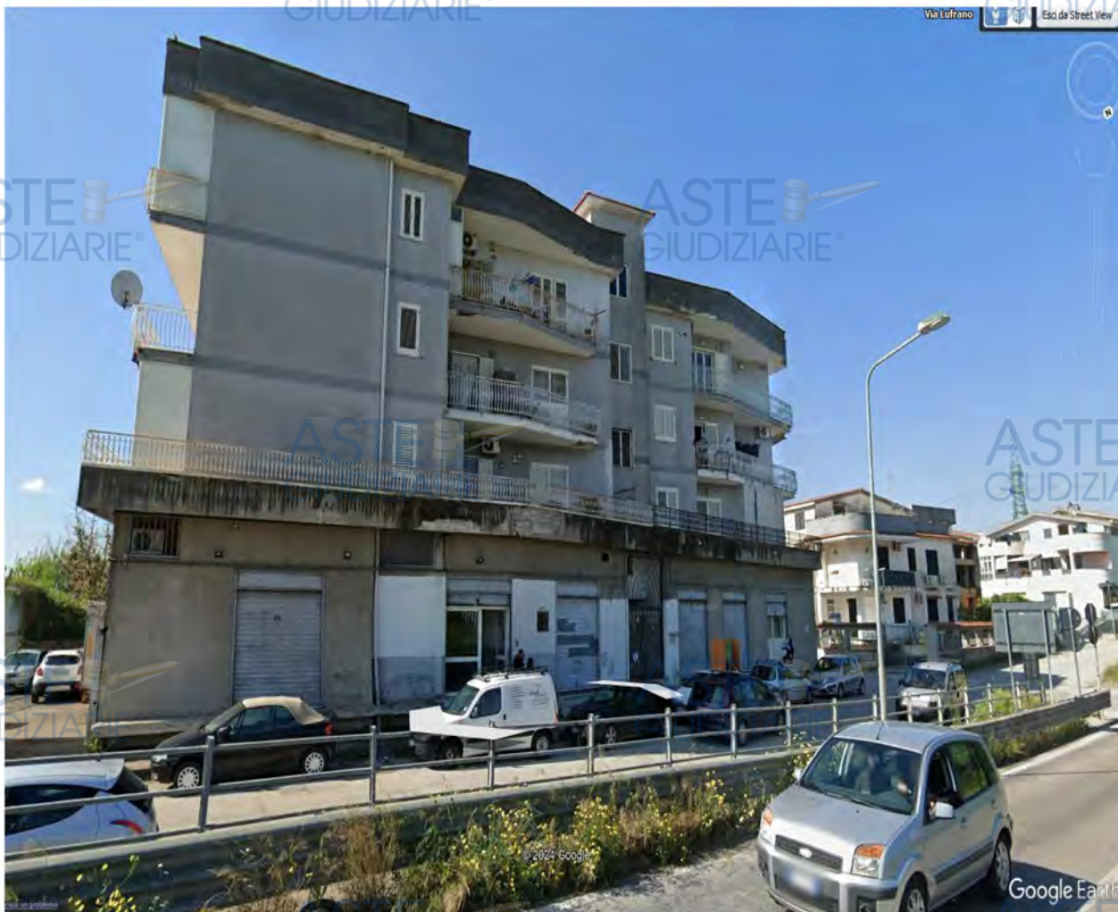
Prospetto dell'immobile preso da Google map
