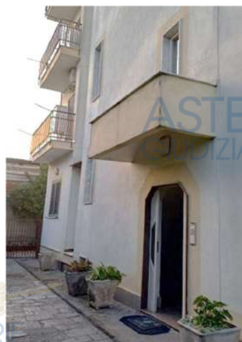
Ingresso vano scala
