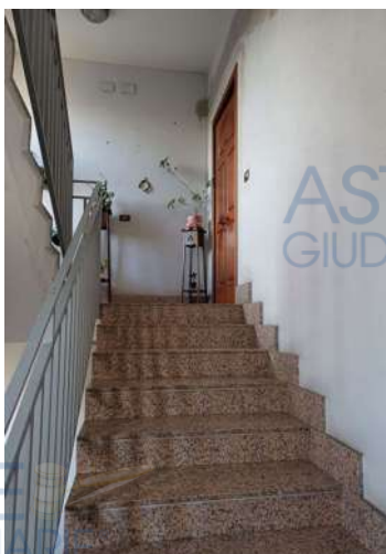
Vano scala – Ingresso appartamento piano secondo –
