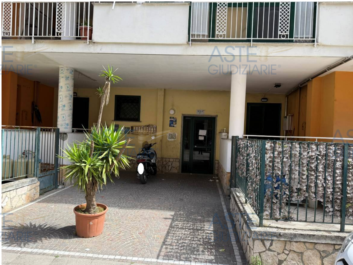
Foto 04 – L'ingresso alla scala F
