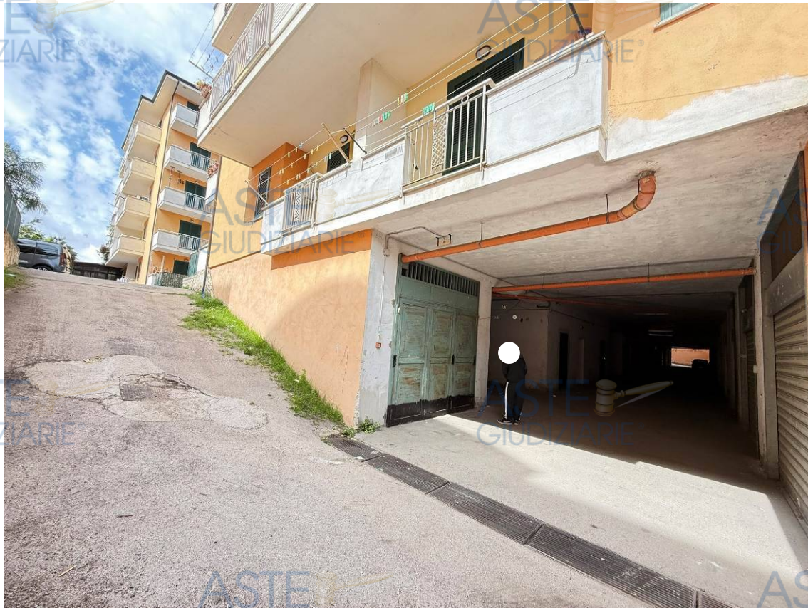
Foto 25 - Ingresso ai box auto piano seminterrato
