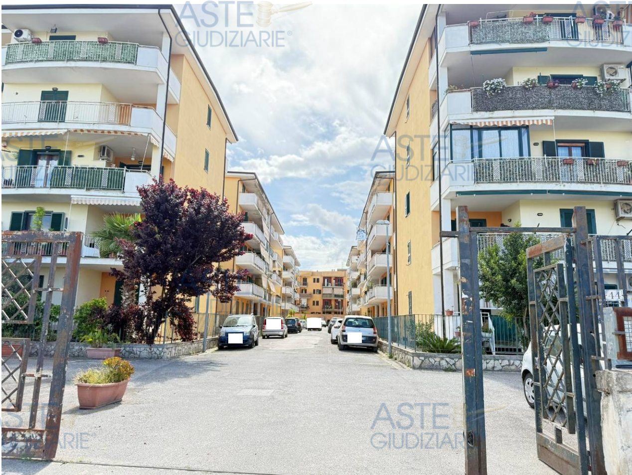
Foto 02 – Il viale interno al complesso immobiliare
