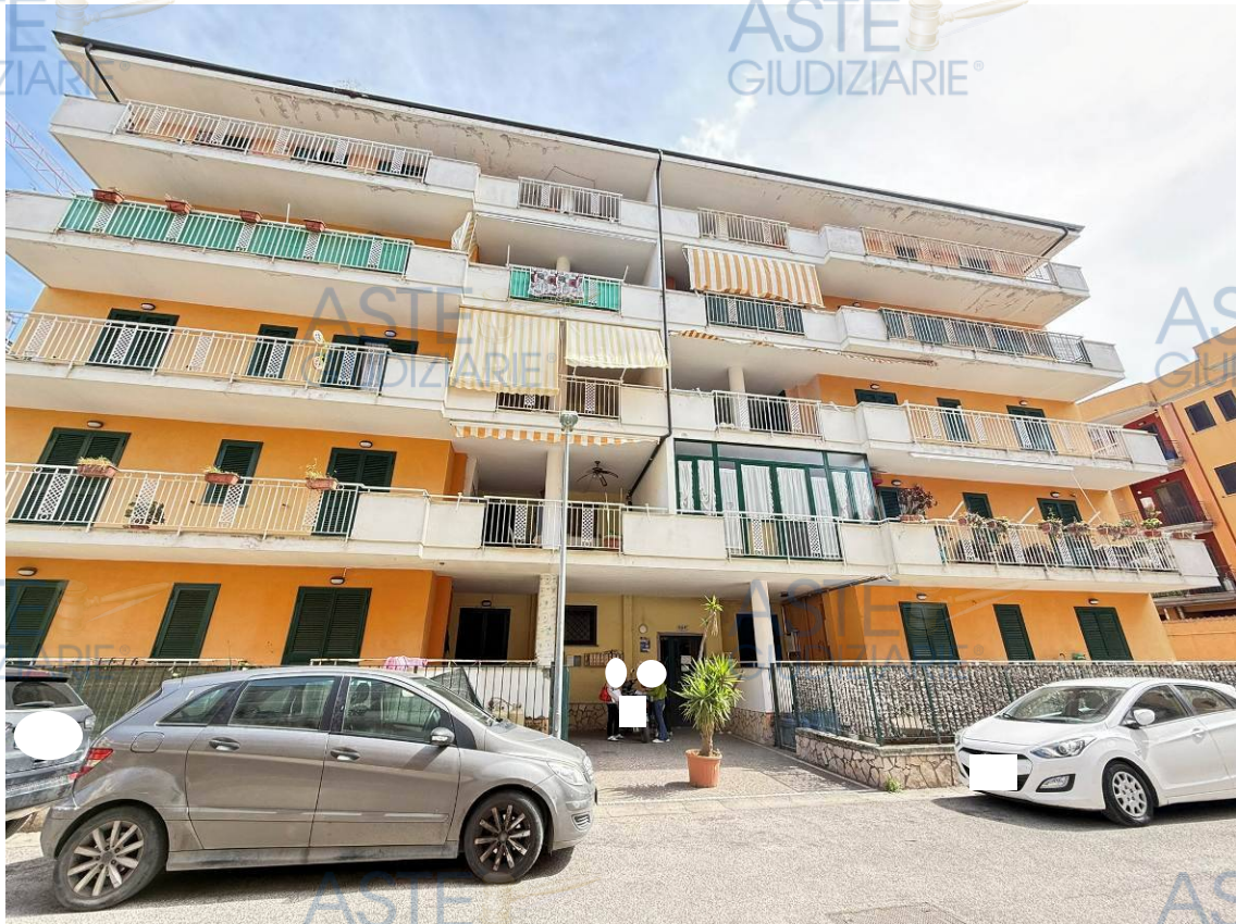
Foto 03 – Il fabbricato scala F dal viale interno al complesso immobiliare
