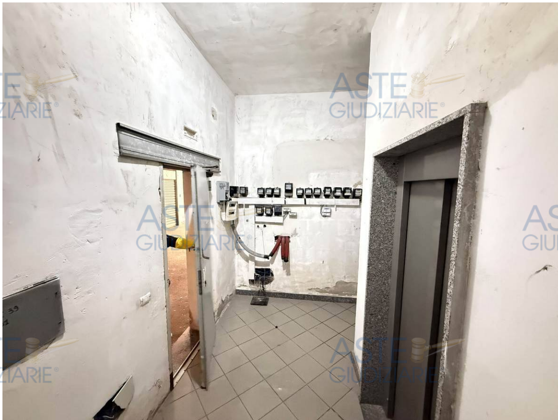
Foto 26 - Scale comuni al piano seminterrato
