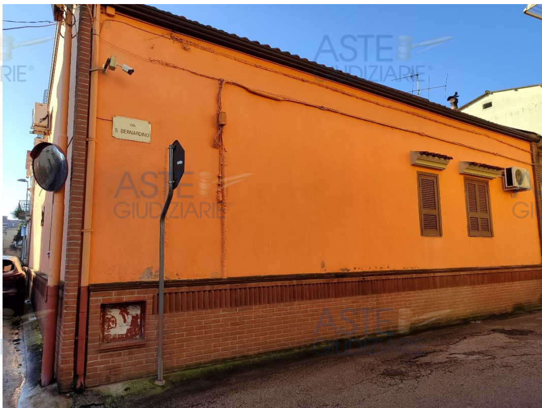
Vista facciata nord da via San Bernardino
