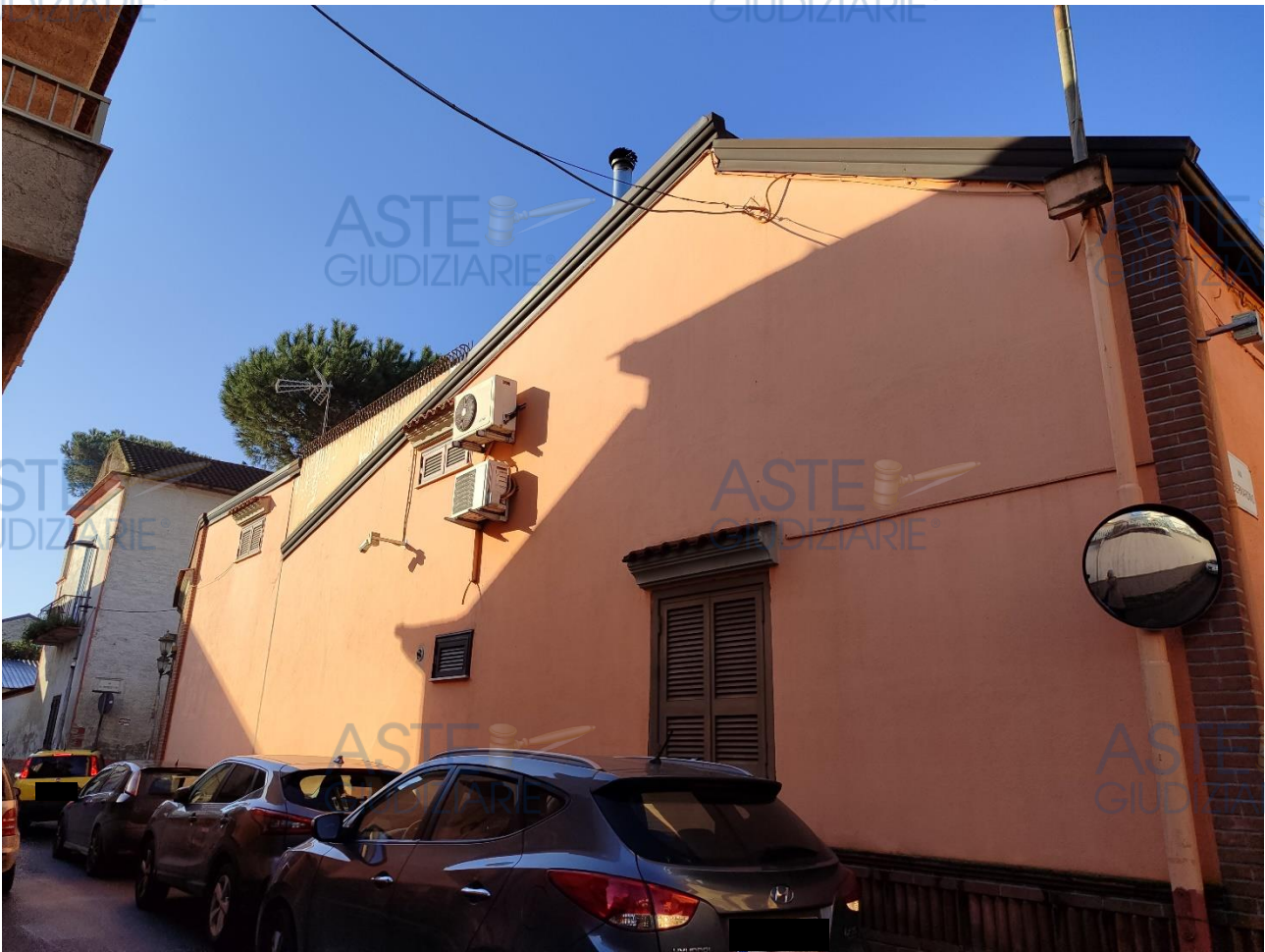
Vista facciata Est da via Regina Elena
