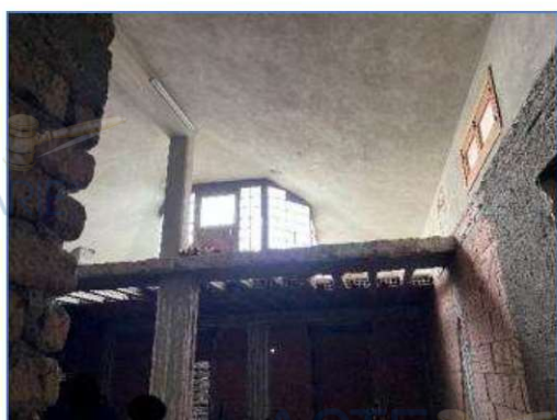
Fotografia 9 – Solaio demolito
