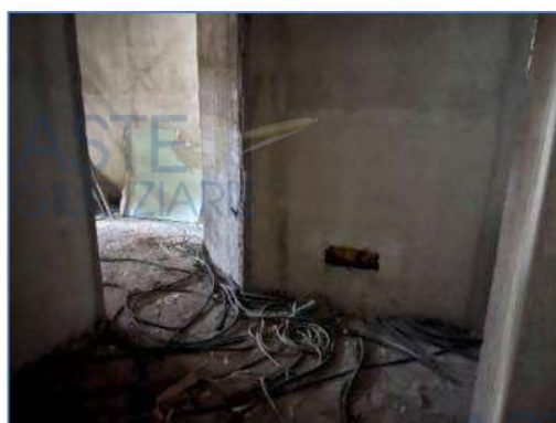
Fotografia 10 – Locali piano secondo
