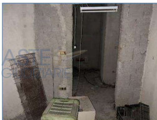
Fotografia 12 – Locali piano secondo
