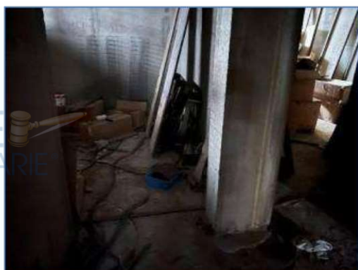
Fotografia 11 – Locali piano secondo
