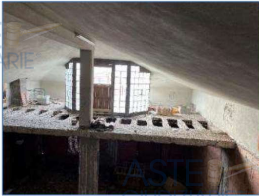
Fotografia 15 – Sottotetto solaio demolito
