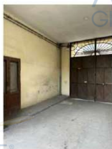
Foto n. 2 - Androne del fabbricato
