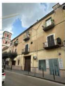
Foto n. 1 - Esterno del fabbricato in cui è ubicato l'immobile pignorato
