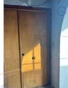
Foto n. 8 - Ingresso all'immobile pignorato dal vano scala
