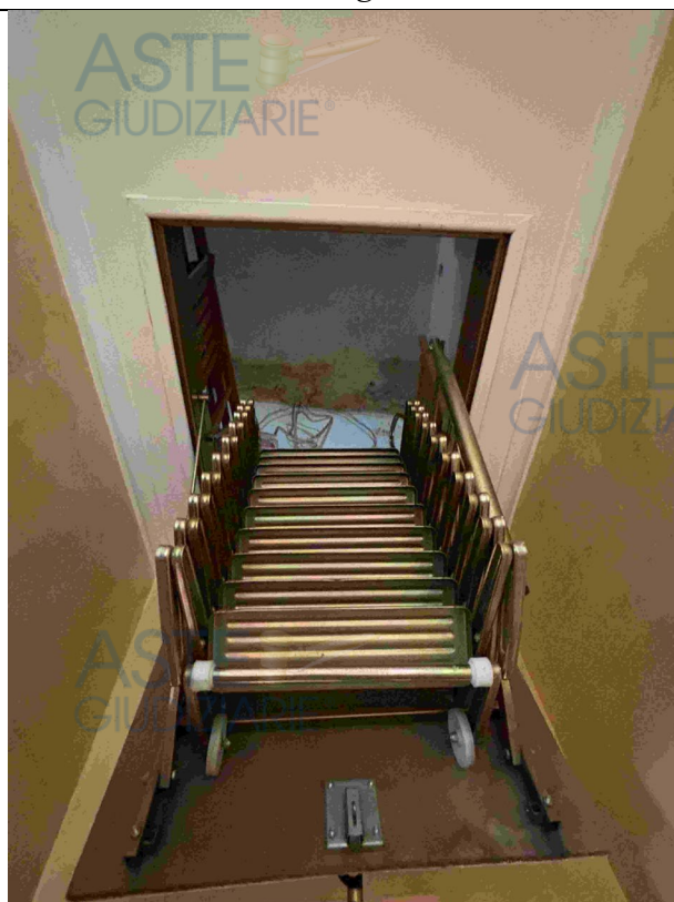
Vista interna botola con accesso a controsoffittatura del disimpegno
