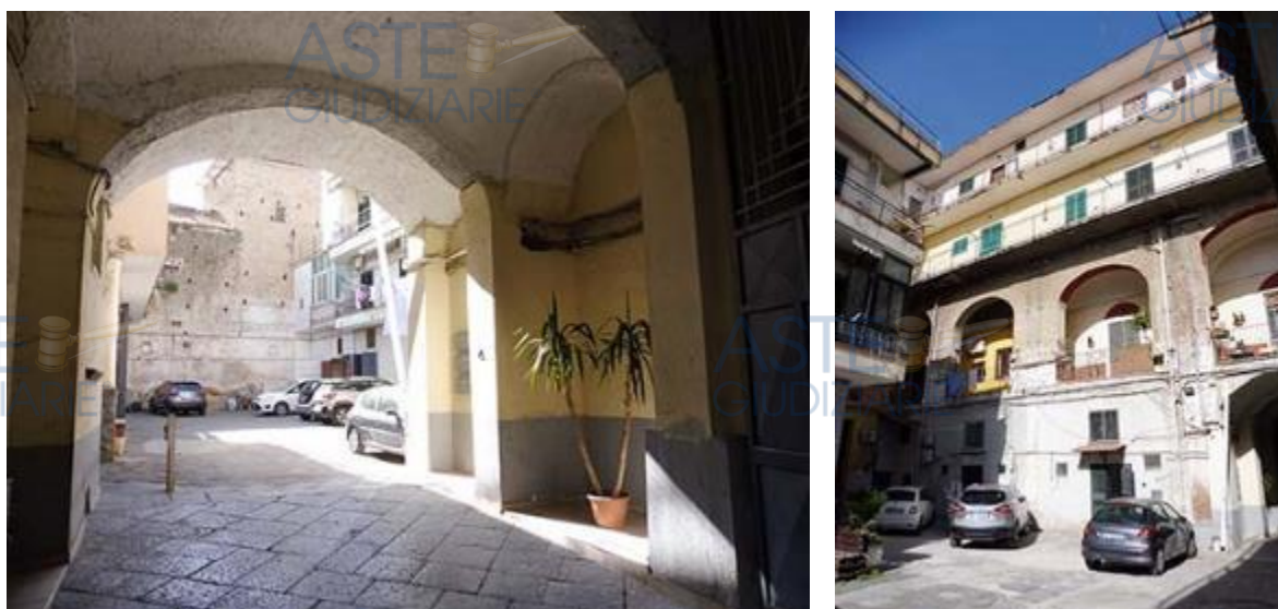
_androne e vista interna del Fabbricato dal cortile
