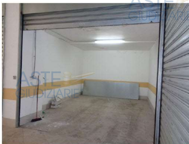
Particolare del locale deposito (adibito a box auto) SUB 39
