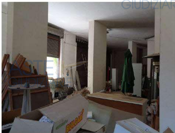
Particolare del locale deposito SUB 47
