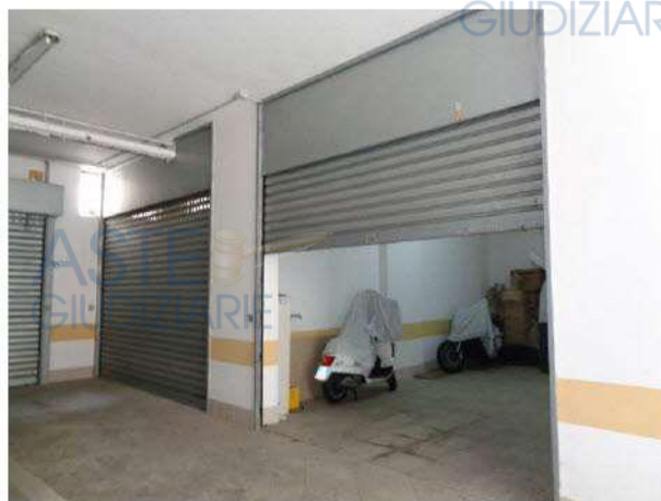
Particolare del locale deposito (adibito a box auto) SUB 48
