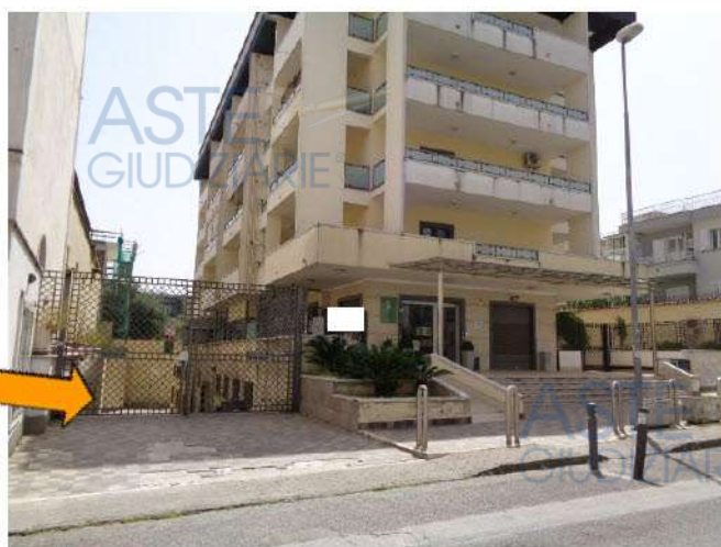
Veduta esterna del fabbricato da Via Orazio
