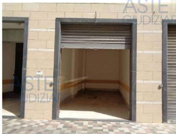
Particolare del locale deposito (adibito a box auto) SUB 44
