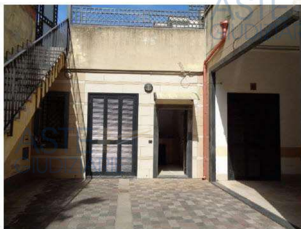
Particolare dell'ingresso al locale deposito (adibito ad ufficio) SUB 43
