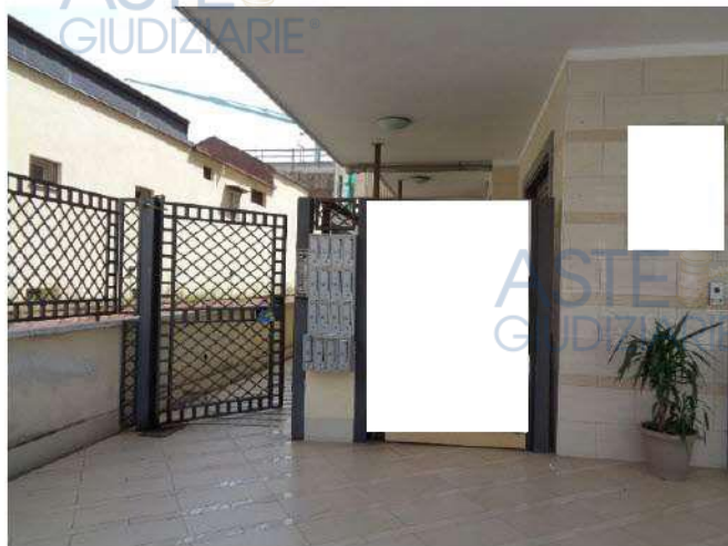
Cancello di ingresso al fabbricato da area scoperta (area urbana – SUB 5)
