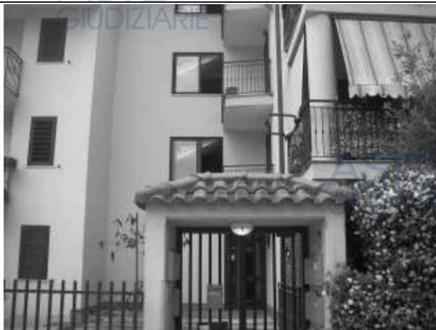
(foto 2: prospetto principale)
