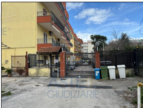
Foto 1 – Accesso al fabbricato - civico 12.
