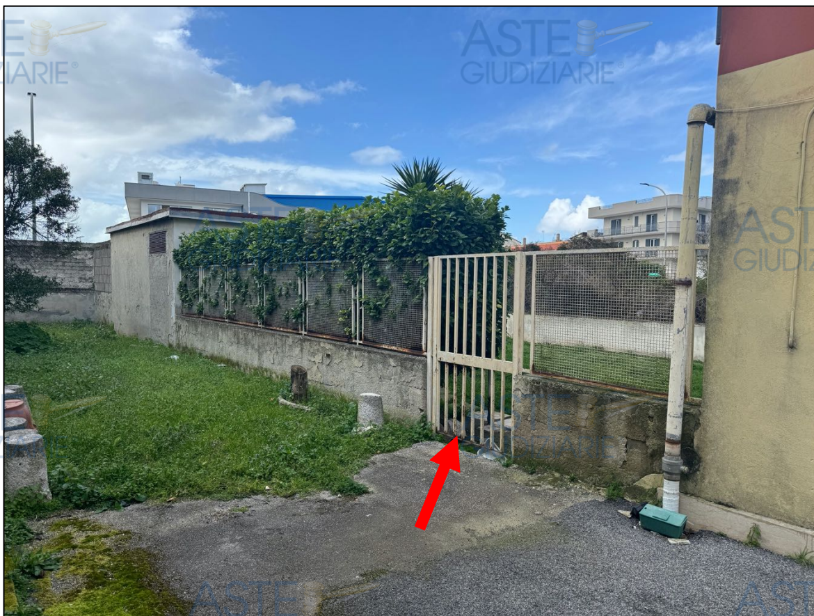
Foto 21 – Accesso esterno ad area di pertinenza esclusiva – Particella graffata 890
