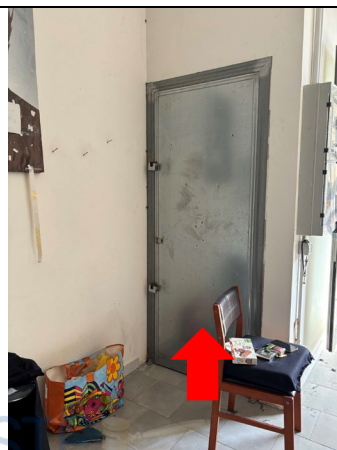
Vista interna dell'ingresso al vano scala
