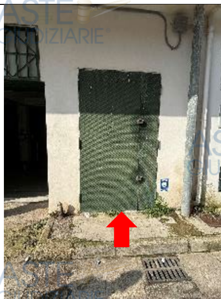
Vista esterna dalla strada - accesso al b.c.n.c.
