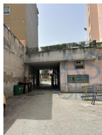
Foto n. 2 - Cortile interno del fabbricato dall'ingresso su strada
