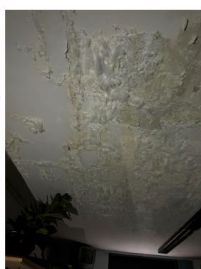
Foto n. 12 - Ambiente n. 1 - soffitto
