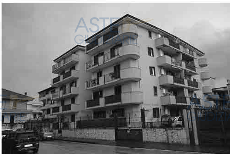
Imm.2.04: viste del fabbricato dalla strada
