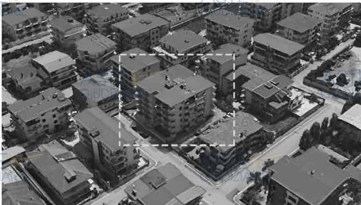
Imm.2.03: vista aerea del fabbricato (estratto da Street View®)
