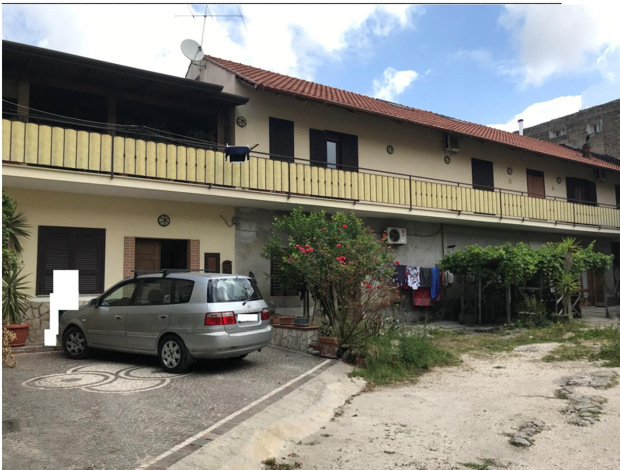
Prospetto dell'edificio cui fa parte l'appartamento staggito visto dal cortile interno; esso è costituito al piano terra dal vano visibile sulla sinistra in tinta beige, altresì al piano primo si sviluppa per tutta la lunghezza.
