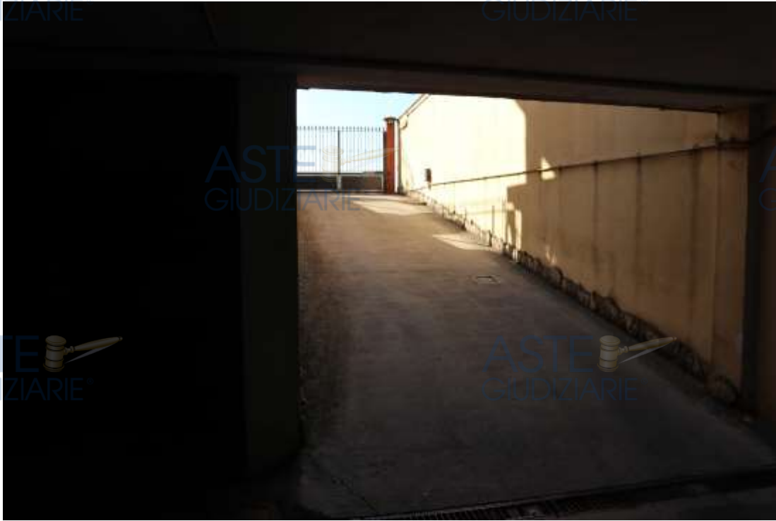
RAMPA DI ACCESSO AL GARAGE
