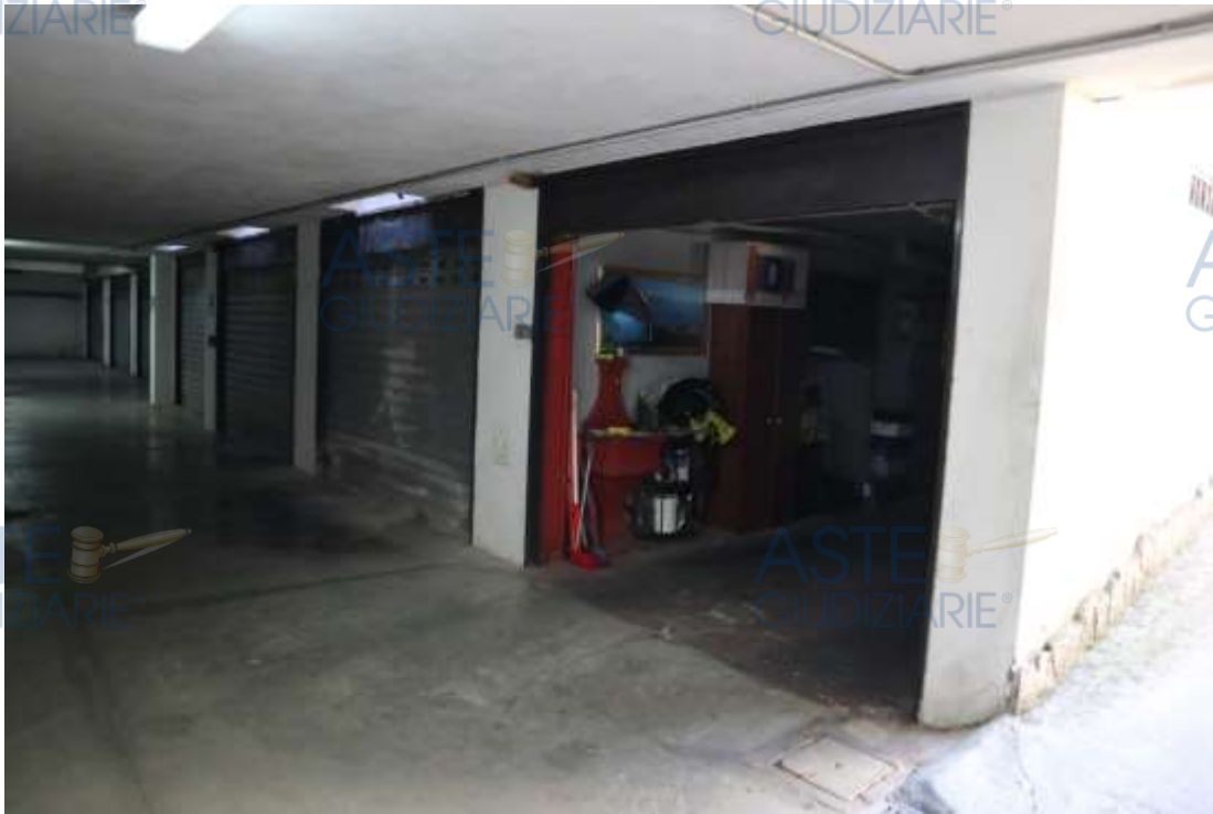
VISTA ESTERNA DEL BOX AUTO
