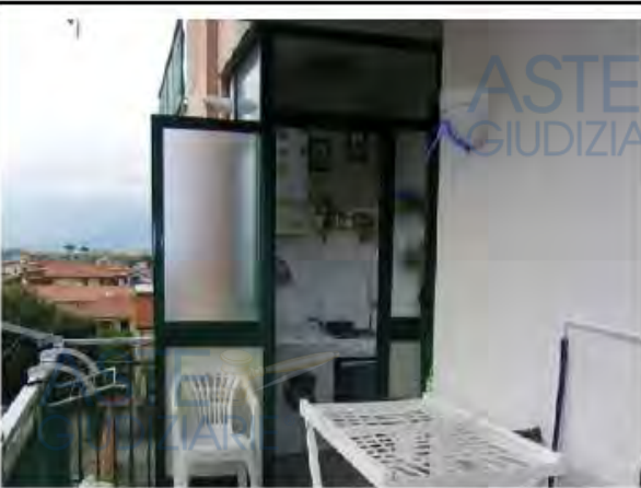
Foto 9 - la veranda ubicata sul balcone a servizio del soggiorno e della cucina
