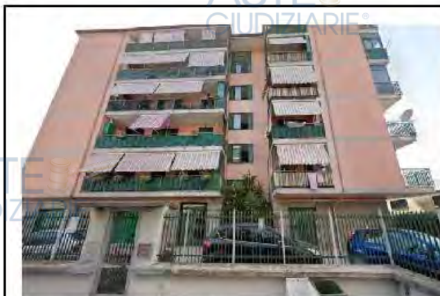
Foto 1 - prospetto dell'edificio sul vicolo cieco di via Giulio Cesare
