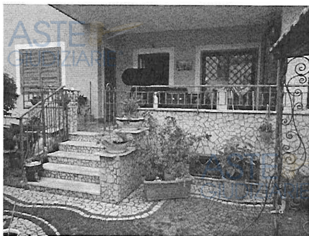
Portoncino d'ingresso al villino SUB 3
