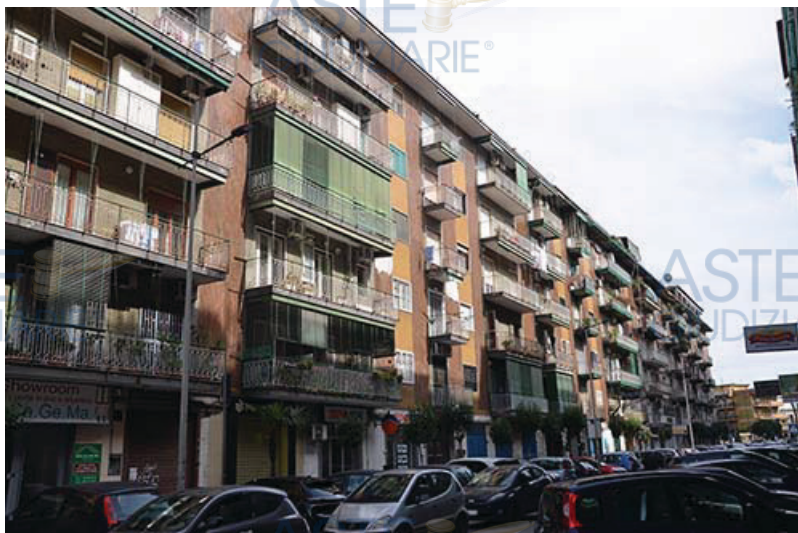
imm.2.03: viste del fabbricato dalla strada
