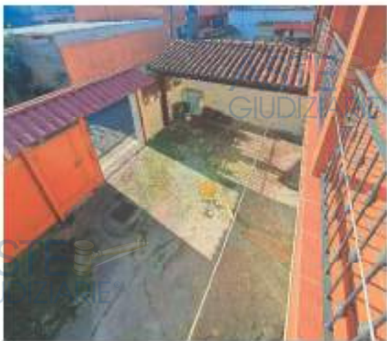
Immagine n.6: Vista tettoia e cortile lato Ovest
