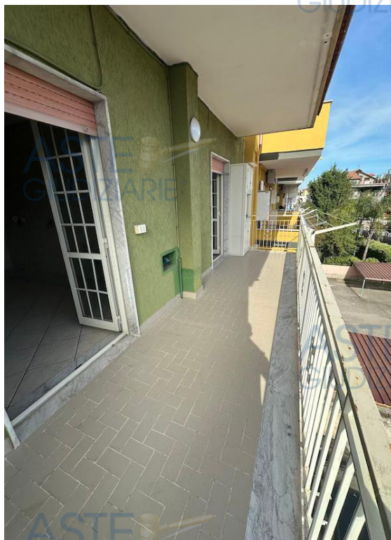
Foto n.6 – particolare balcone lato Sud
