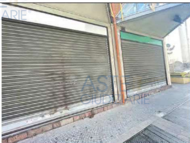
Fotografia n. 3 _ Prospetto del locale commerciale su via Aniello Palumbo
