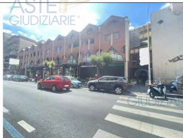
Fotografia n. 2 _ Prospetto su via Aniello Palumbo, vista ovest/est
