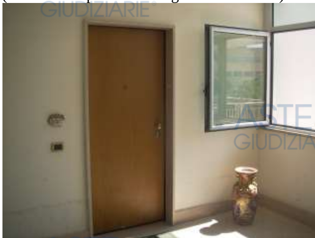
(foto 4: vista porta ingresso appartamento)
