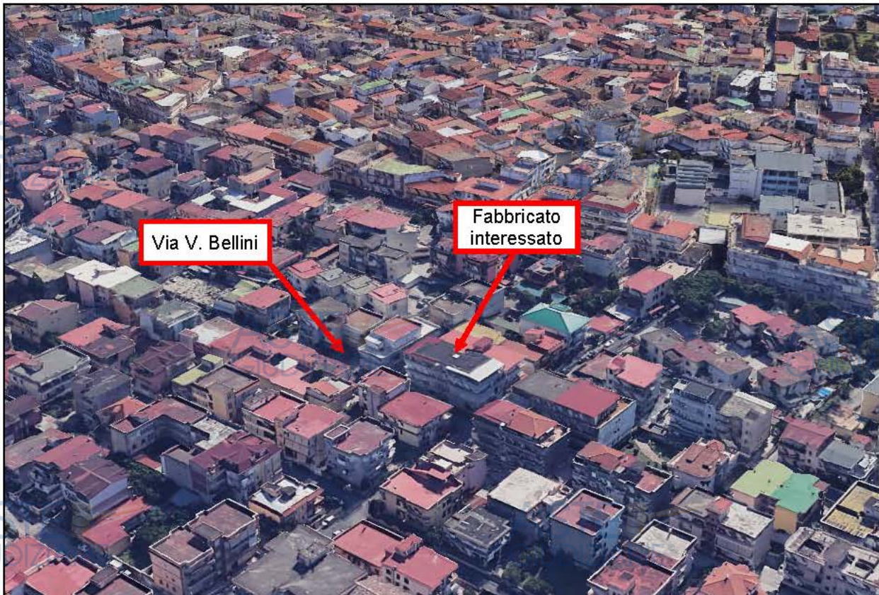
Vista satellitare dell'area oggetto di perizia
