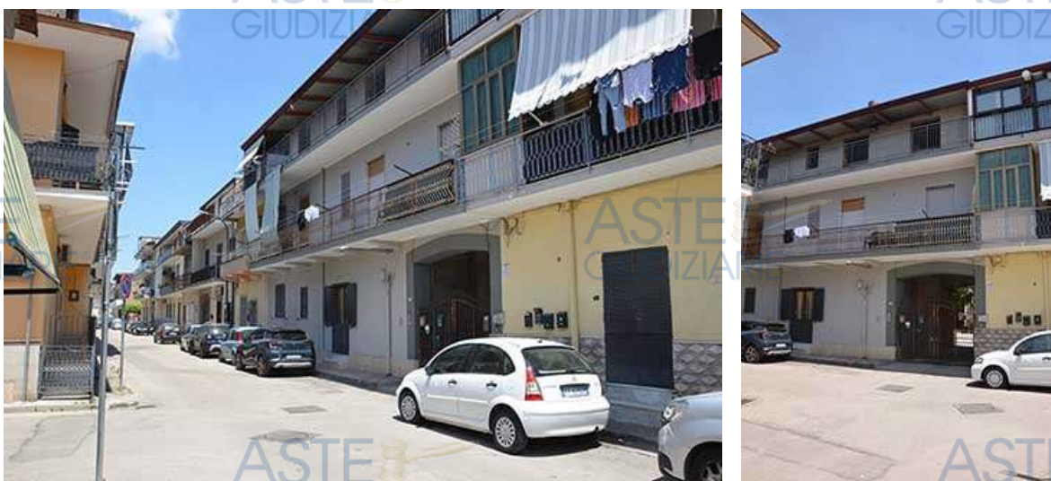
imm2.03: viste del portone di accesso dalla strada
