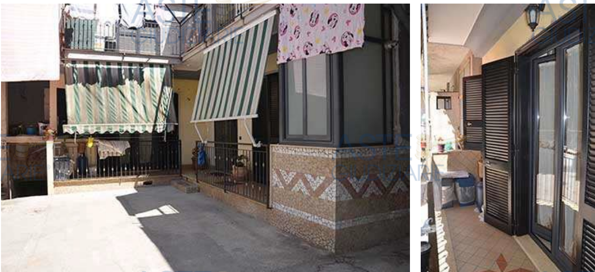
imm2.05: viste del ballatoio esterno
