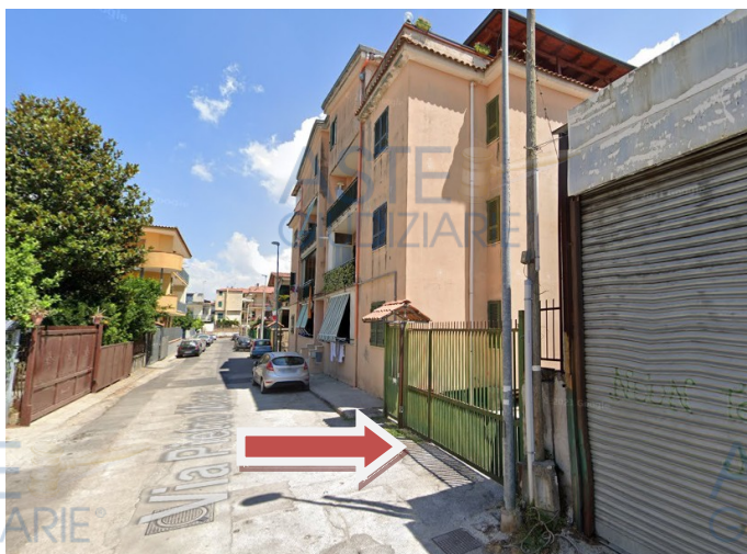
Ingresso al cortile
