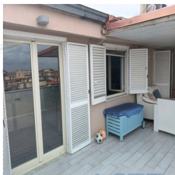
Pavimentazione terrazza e infissi
