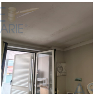
Dettaglio infissi esterni
