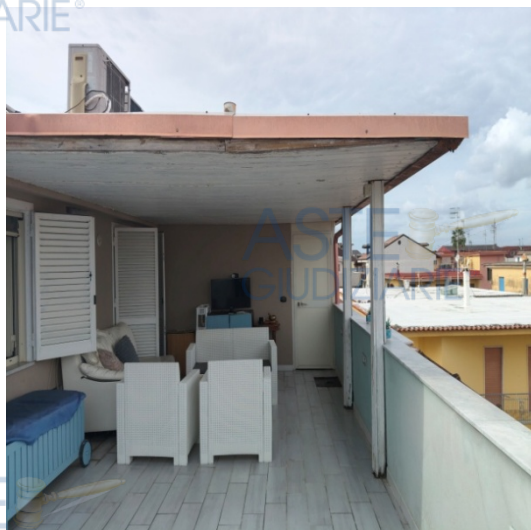
Terrazza grande a nord-vista tettoia
