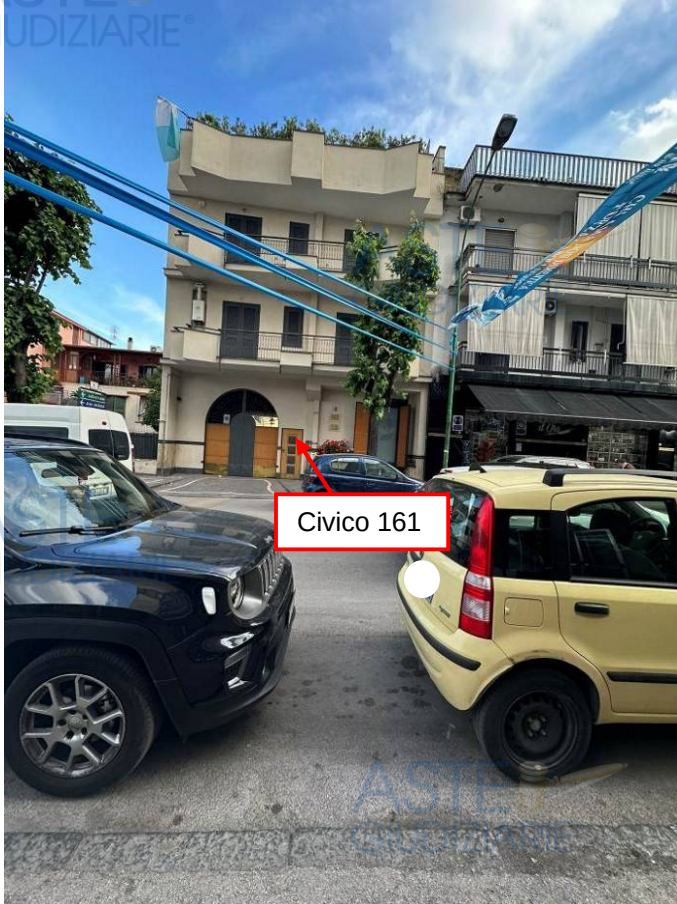
Foto 01 – Il fabbricato dalla via A. De Gasperi
