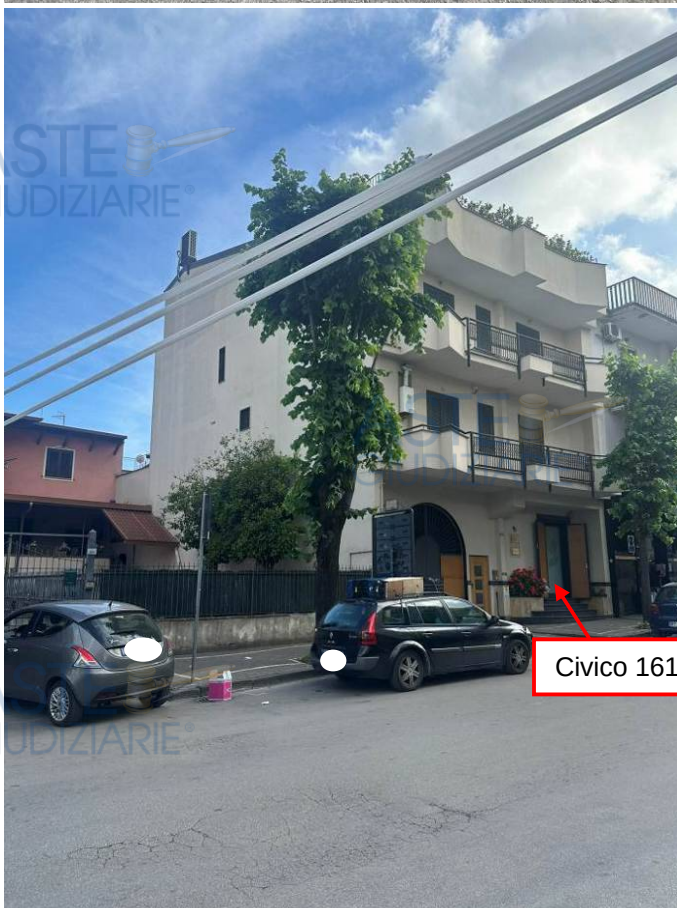
Foto 02 – Il fabbricato dalla via A. De Gasperi
