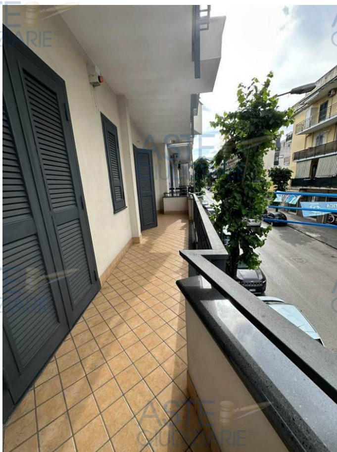
Foto 31 - Il sub 5 – balcone b
