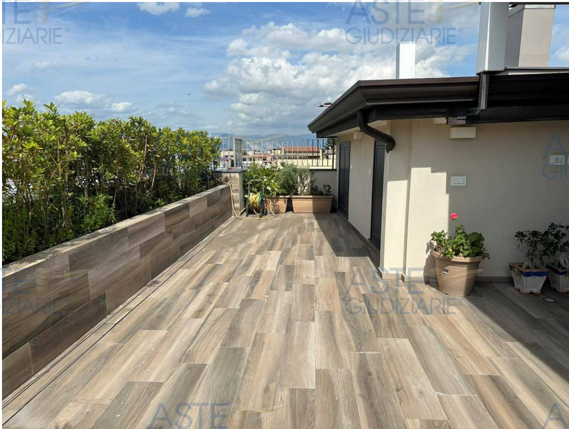
Foto 43 - Il sub 8 – terrazzo
