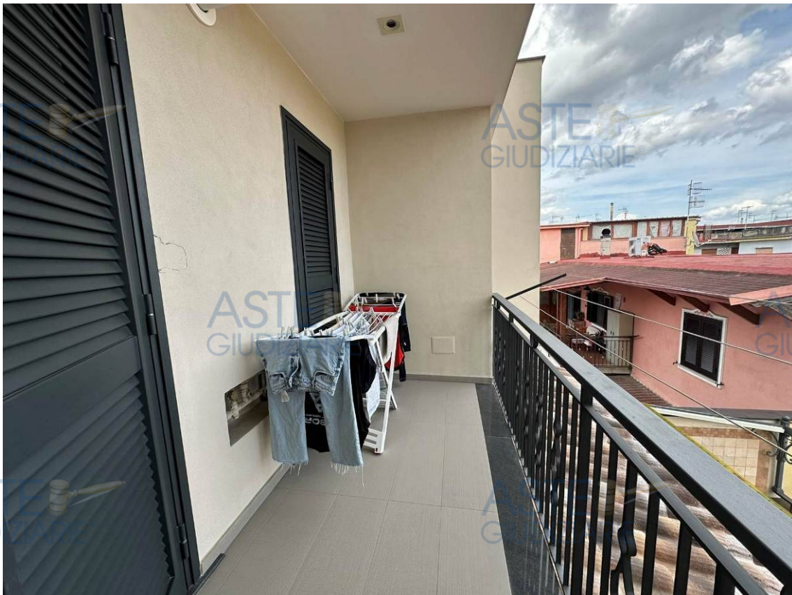
Foto 20 - Il sub 8 – balcone b2
