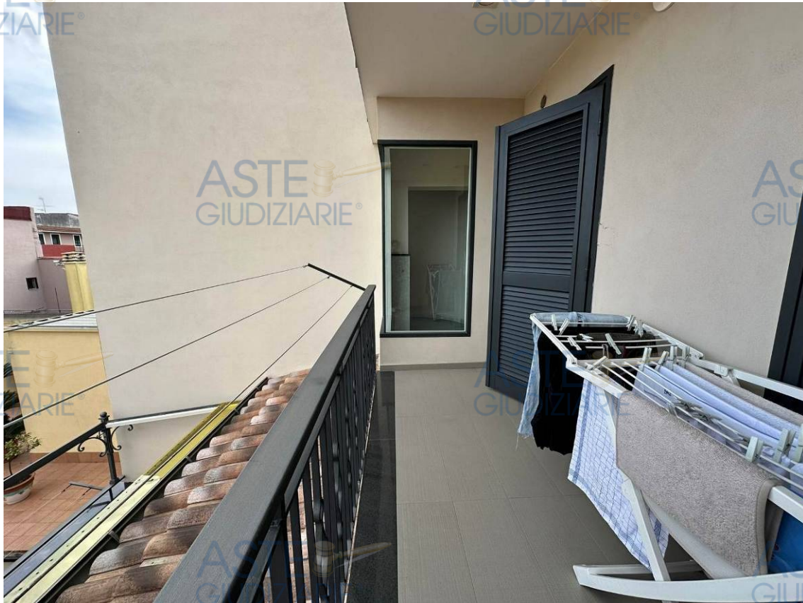
Foto 19 - Il sub 8 – balcone b2
