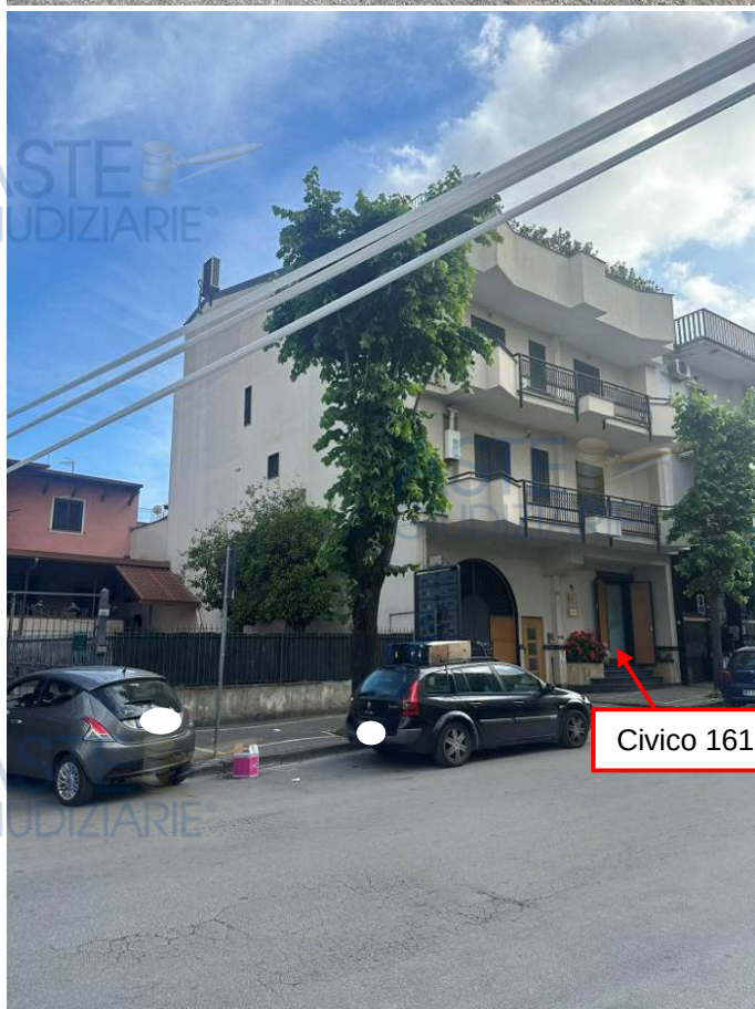
Foto 02 – Il fabbricato dalla via A. De Gasperi
