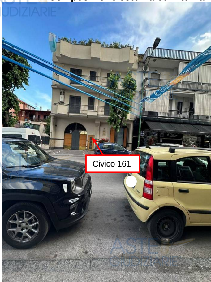
Foto 01 – Il fabbricato dalla via A. De Gasperi
