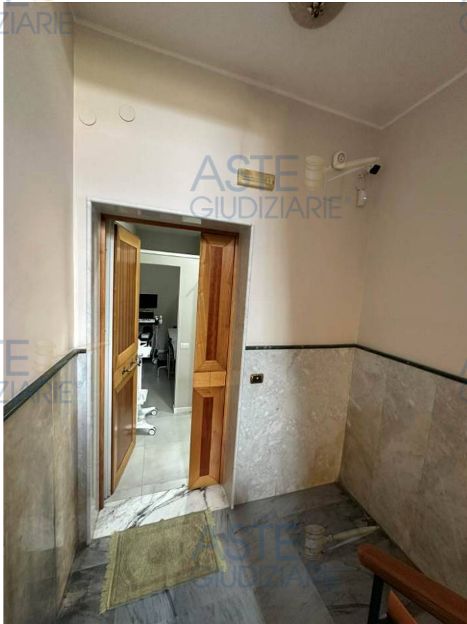
Foto 13 - Il sub 7 – ingresso dalle scale comuni
