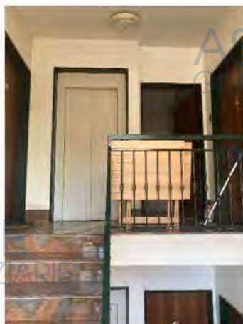
Foto ballatoio d'accesso immobile
