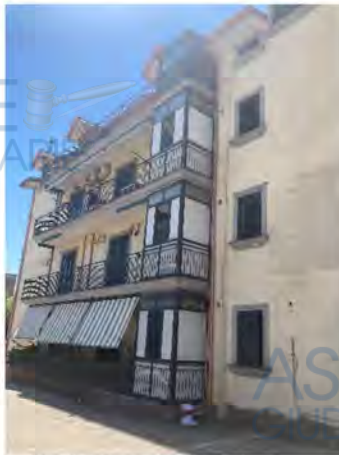
Foto esterno fabb.to lato nord
