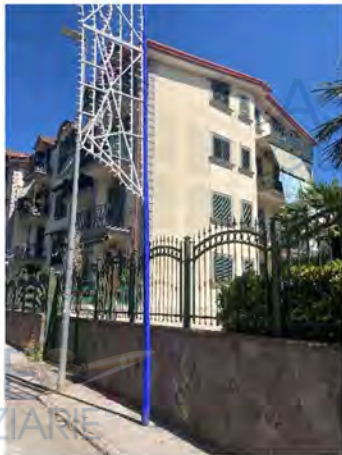
Foto esterno fabb.to lato sud_est
