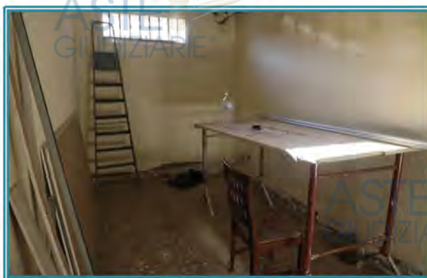
Figura 43 Cantina al piano seminterrato
