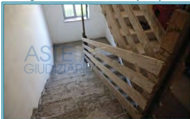
Figura 13 Scala comune allo stato grezzo (sub. 1)
