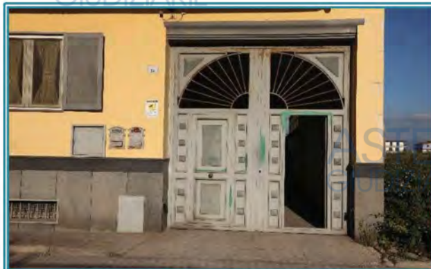
Figura 9 Ingresso al cortile comune del fabbricato
