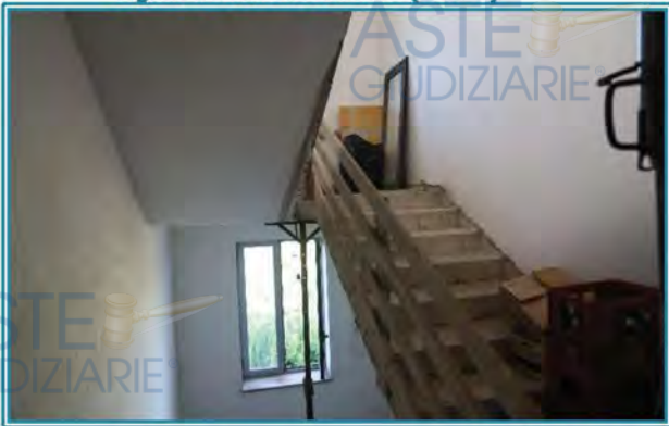
Figura 14 Scala comune allo stato grezzo (sub. 1)
