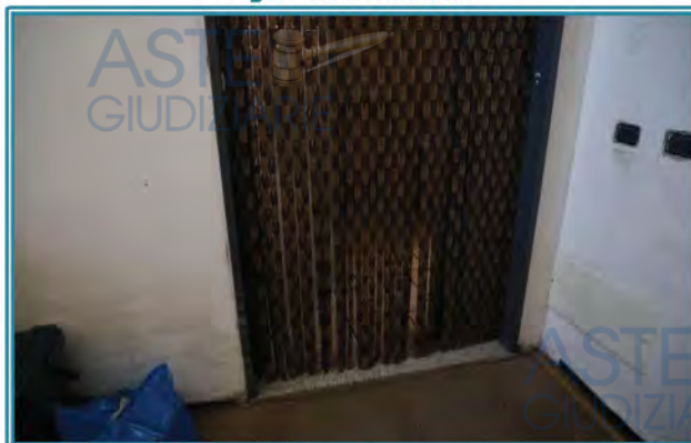
Figura 25 Accesso al terrazzo
