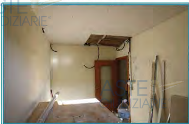
Figura 42 Cantina al piano seminterrato
