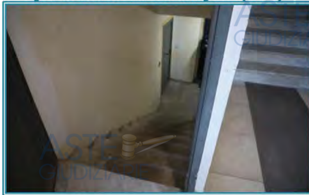
Figura 15 Scala di accesso al piano cantinato (sub. 1)
