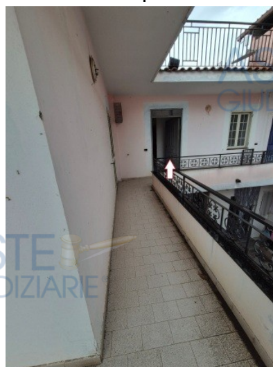
Figura 85 balcone dell'appartamento al primo piano interno 4
