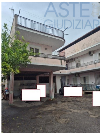
Figura 40 cortile comune e facciata sud del fabbricato a cui appartiene l'immobile pignorato in Caivano alla SS 87 km 14,500
