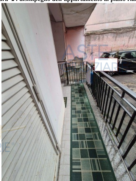
Figura 26 balcone dell'appartamento al piano rialzato
