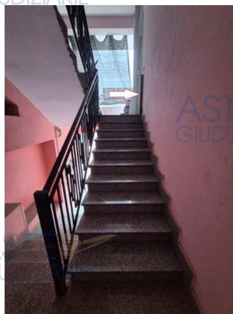
Figura 45 accesso dal vano scala all'appartamento al primo piano interno n.3
