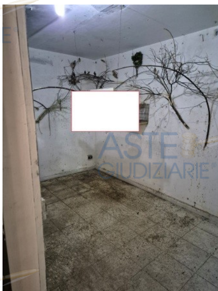
Figura 96 deposito al piano terra
