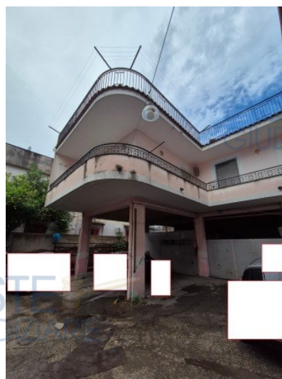
Figura 95 cortile comune e facciata ovest del fabbricato a cui appartiene l'immobile pignorato in Caivano alla SS 87 km 14,500
