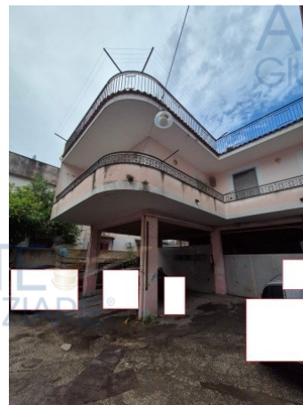
Figura 9 cortile comune e facciata ovest del fabbricato a cui appartiene l'immobile pignorato in Caivano alla SS 87 km 14,500
