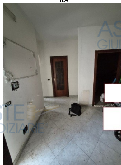
Figura 73 disimpegno dell'appartamento al primo piano interno 4
