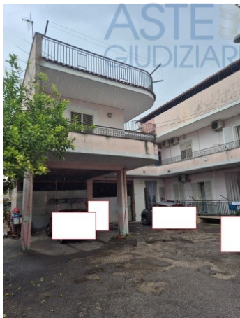
Figura 8 cortile comune e facciata sud del fabbricato a cui appartiene l'immobile pignorato in Caivano alla SS 87 km 14,500
