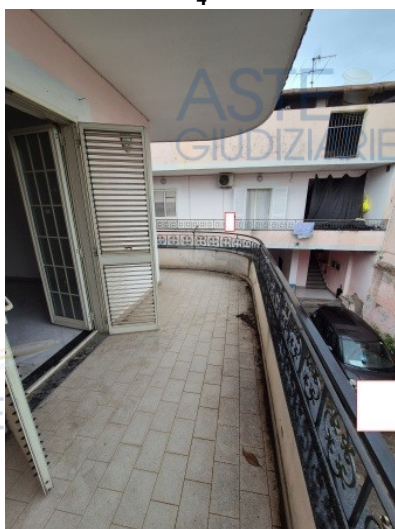
Figura 84 balcone dell'appartamento al primo piano interno 4
