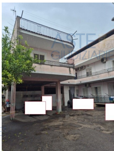
Figura 94 cortile comune e facciata sud del fabbricato a cui appartiene l'immobile pignorato in Caivano alla SS 87 km 14,500
