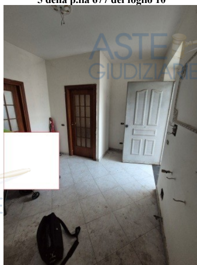
Figura 72 disimpegno dell'appartamento al primo piano interno 4
