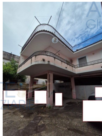
Figura 67 cortile comune e facciata ovest del fabbricato a cui appartiene l'immobile pignorato in Caivano alla SS 87 km 14,500
