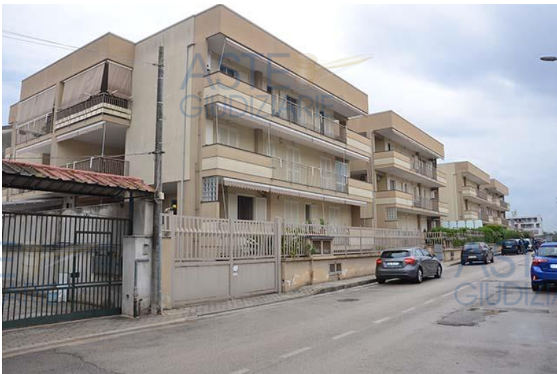
imm.2.03: viste dalla strada e cancello di ingresso al seminterrato
