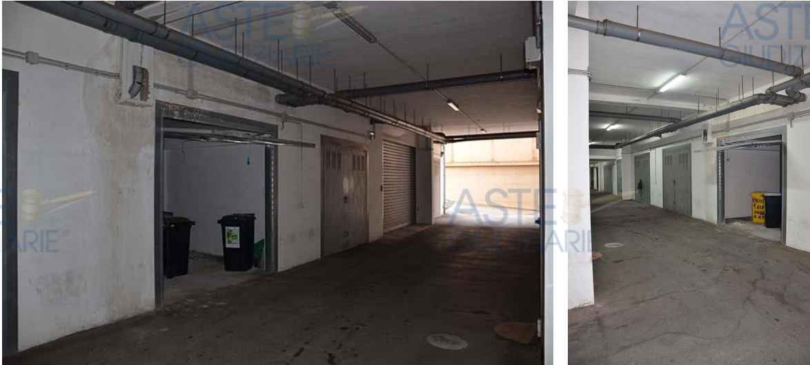
imm.2.08: viste del box dalla corsia di manovra
