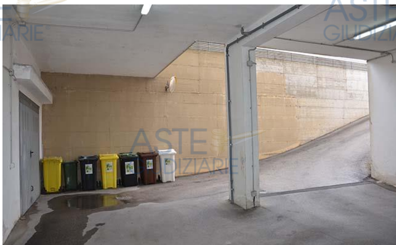
imm.2.07: rampa di uscita
