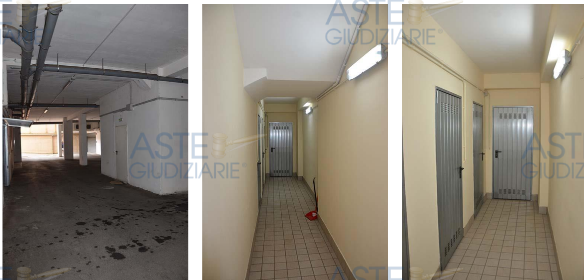
imm.2.10: accesso al blocco A e interno del corpo scala
