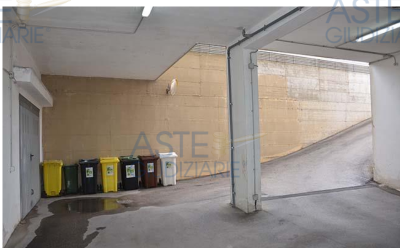
imm.2.07: rampa di uscita
