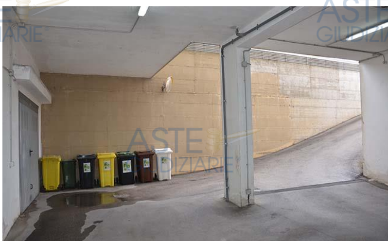
imm.2.07: rampa di uscita
