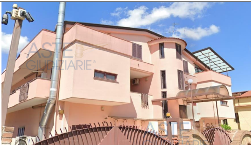
Foto 1 - prospetto dell'edificio su via P. Nenni
