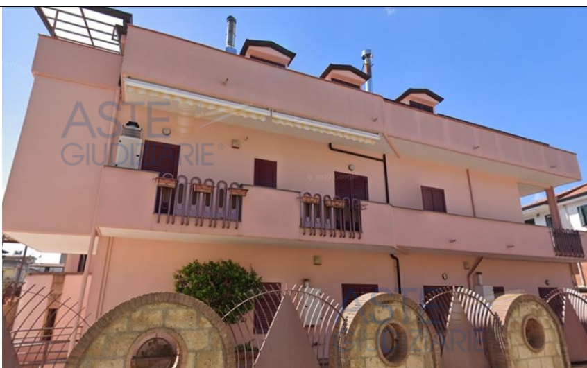
Foto 2 - prospetto dell'edificio su via Giovanni Amendola
