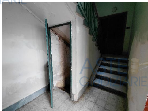
ingresso verso deposito interrato
