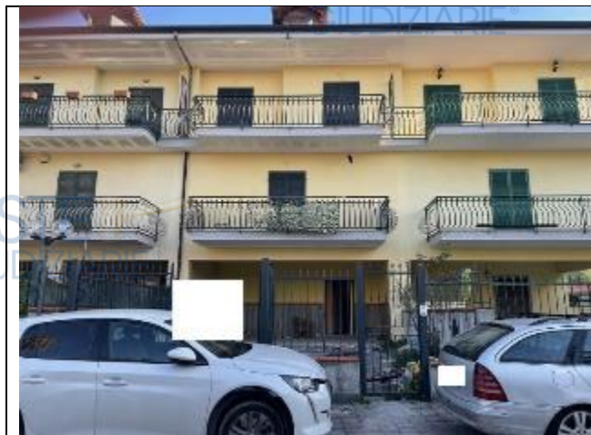
Vista dal cortile condominiale sub 1
