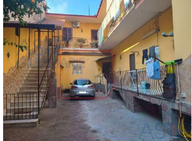
Cortile interno del fabbricato
