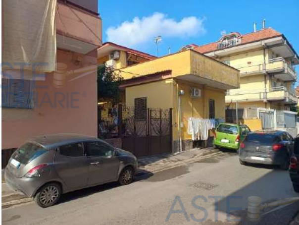
Il fabbricato di cui fa parte l'appartamento
