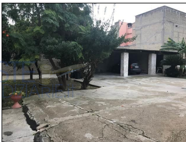
Area esterna al fabbricato
