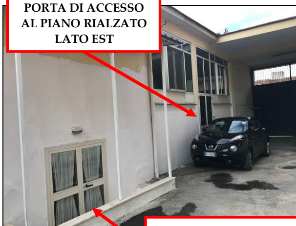
PORTA DI ACCESSO AL PIANO SEMINTERRATO LATO EST
