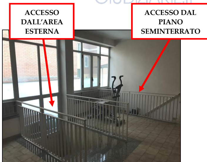
Scale di accesso al piano rialzato
