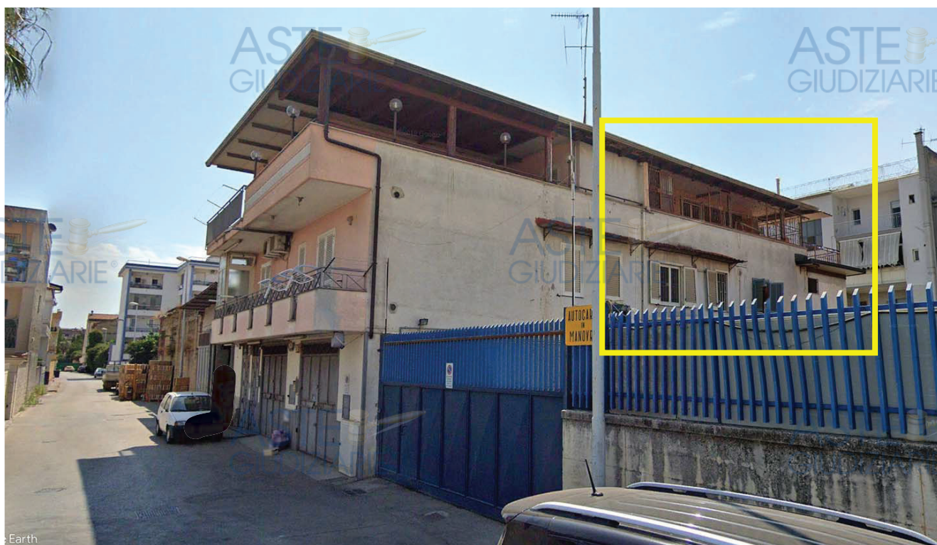
Foto 01. Fabbricato visto da via Giovanni Gentile
