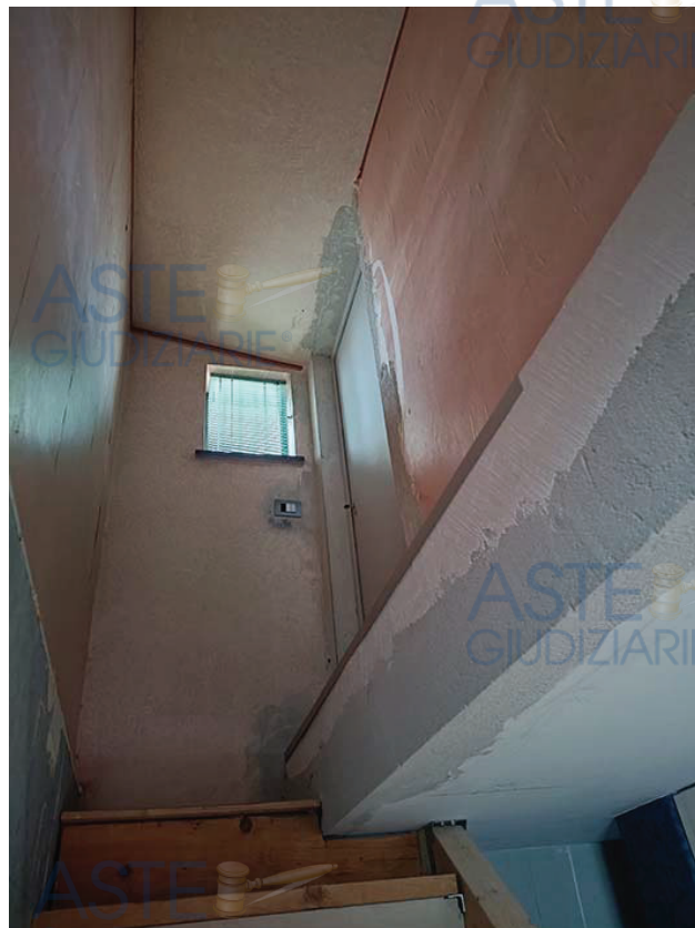
Foto 13. Foro Scala e accesso al P.2
