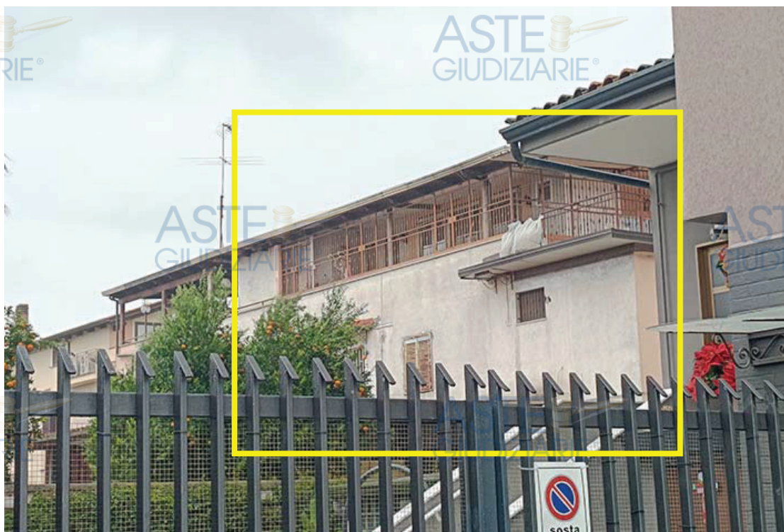
Foto 03. Immobile visto da viale della Libertà
