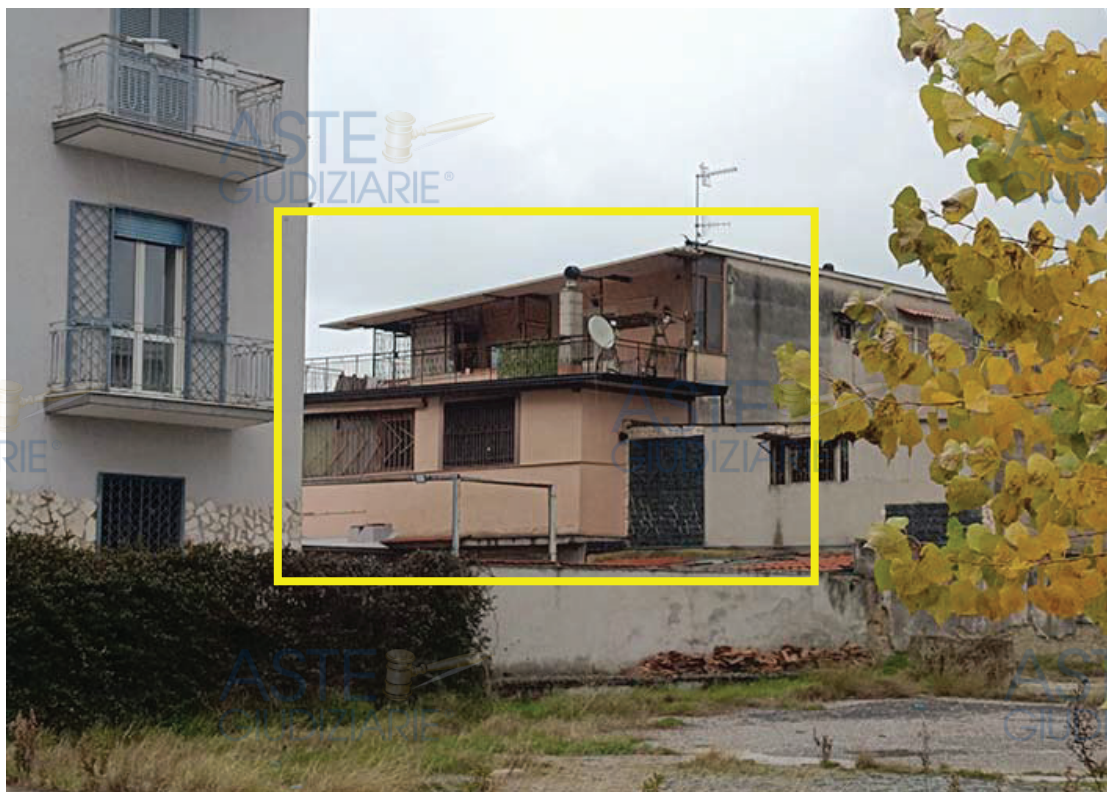
Foto 02. Immobile visto da viale della Libertà
