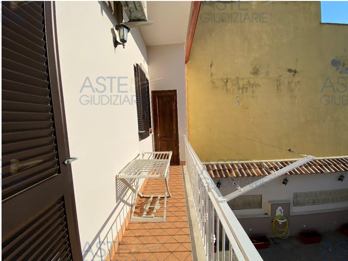
Balcone 2/terrazzo piano primo sub. 4 - lotto 2-
