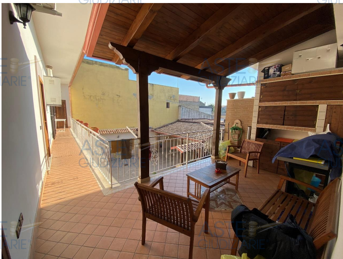
Balcone 2/terrazzo piano primo sub. 4 - lotto 2-
