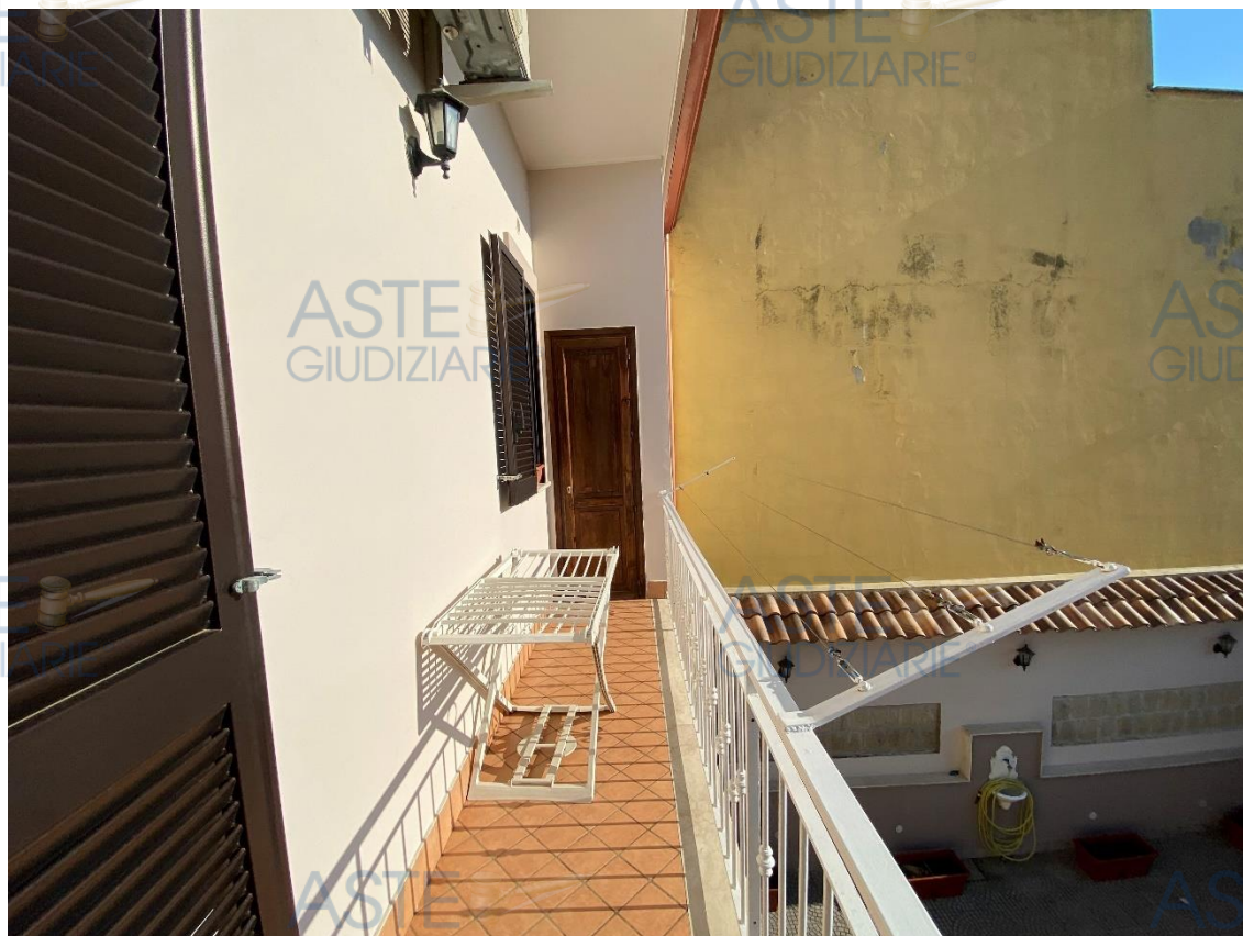
Balcone 2/terrazzo piano primo sub. 4 - lotto 2-
