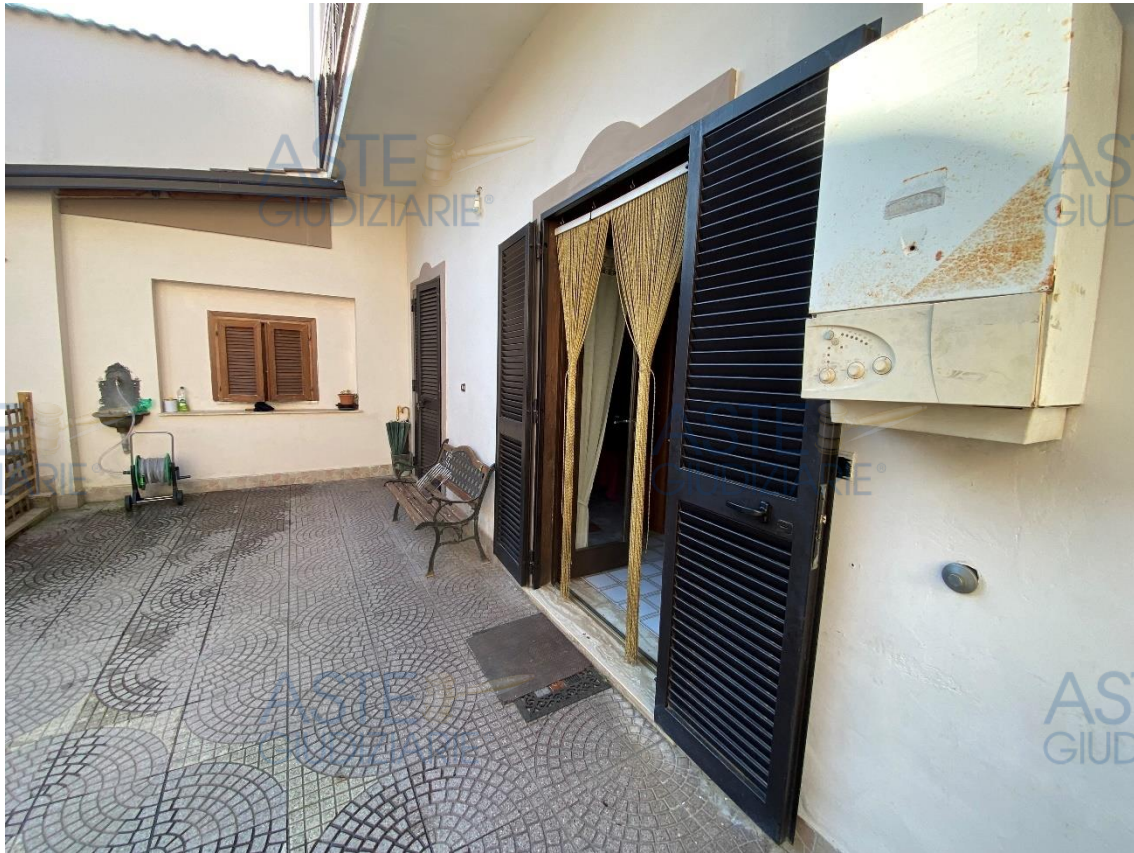
Ingresso piano terra sub. 5 e sub. 6 - lotto 3-
