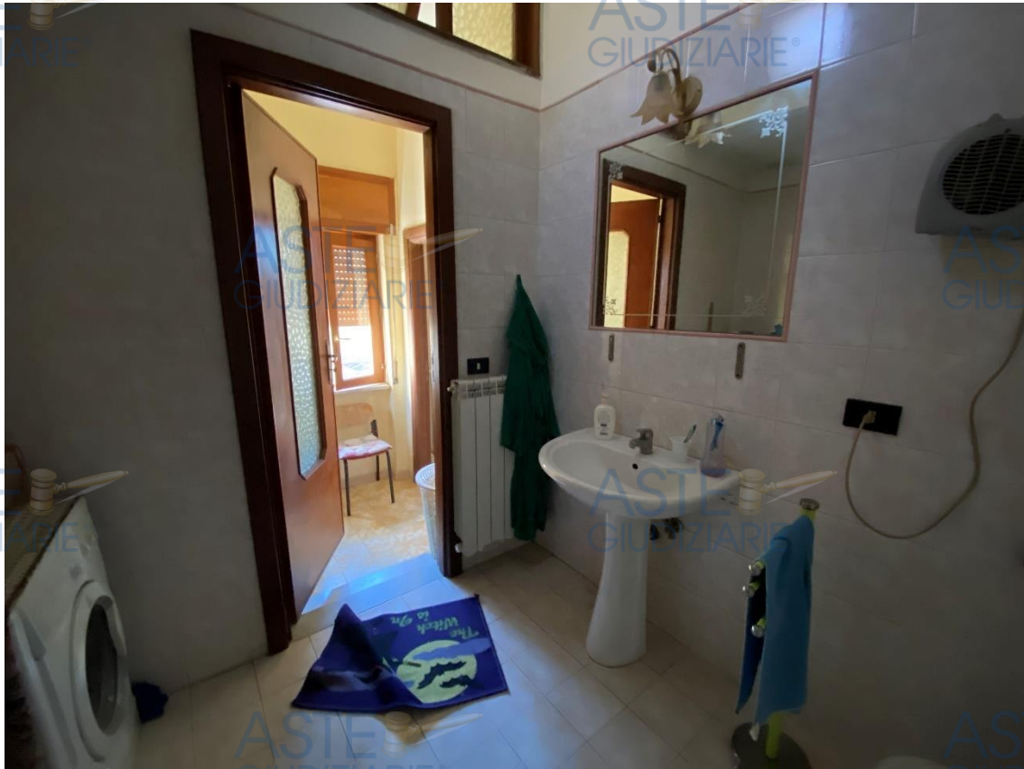
Wc2 piano primo sub. 6 - lotto 3-
