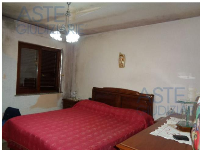
Particolare della camera da letto: macchie di muffa e condensa a soffitto e a parete
