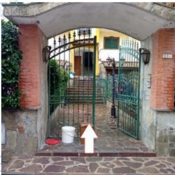
Figura 10 accesso alla scala del fabbricato dal cortile comune su via Umberto Terracini n.23/A in Marano di Napoli
